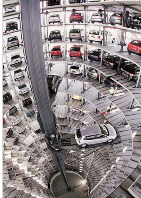
Fig.26 – Parque de estacionamento automático [34]
