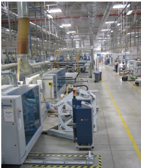
Figura 10 - Vista de uma das linhas da ED&B
