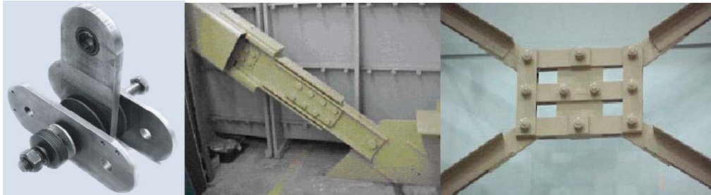
Figura 4.6 – Amortecedor friccional [35]
