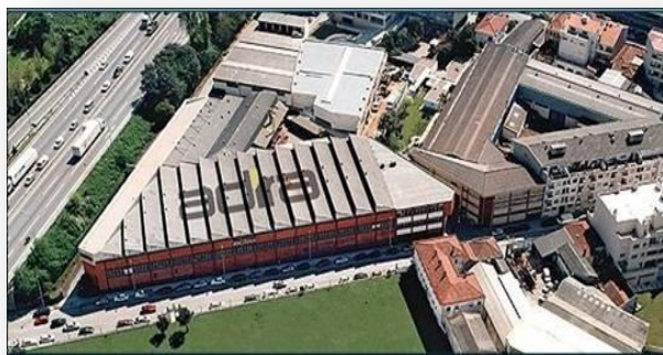
Figura 1.1) Instalações da ADIRA na Rua de Bessa Leite.
