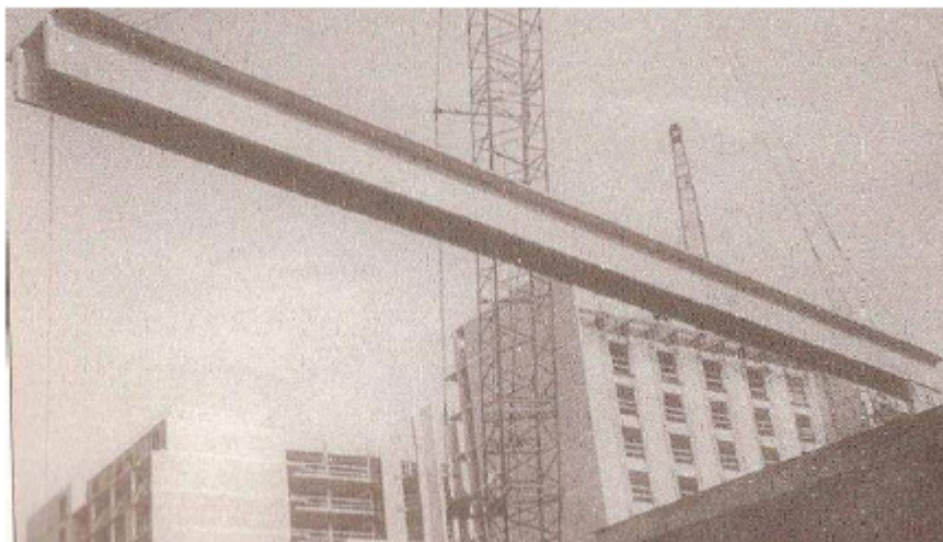
Fig. 5 – Laje em duplo T com 39 m de comprimento [2] .
