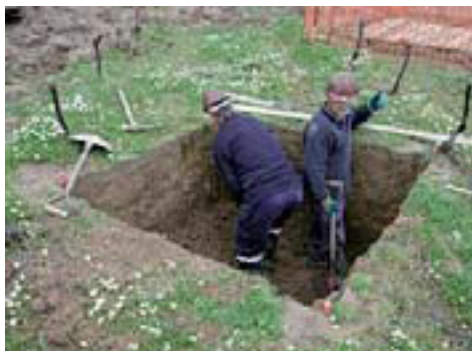
Figura 5.11 – Abertura do cabouco com material adequado [29];
