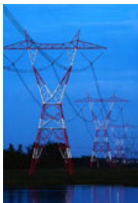
Figura 7.2 – Apoios metálicos com referências para a aviação [33];
