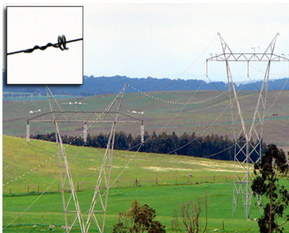
Figura 6.6 - Aplicação de Espanta Pássaros - BFD (Bird Flight Diverter) [39];
