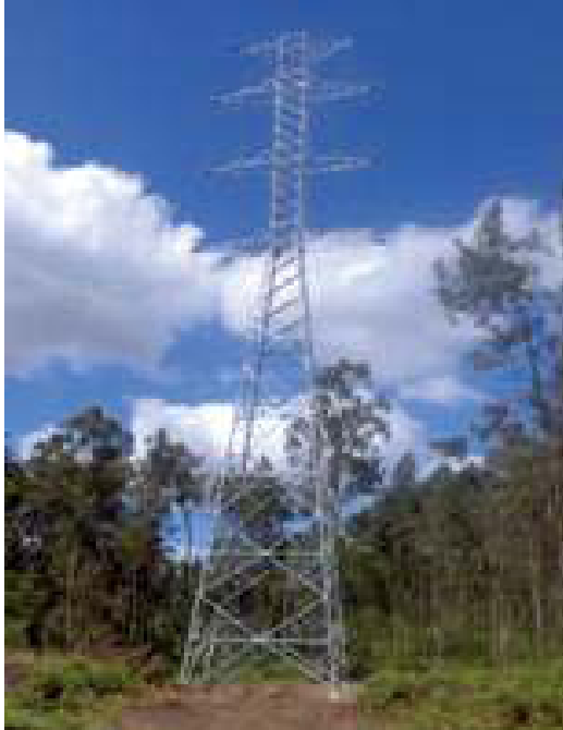
Figura 5.5 - Exemplo de um apoio treliçado [29];
