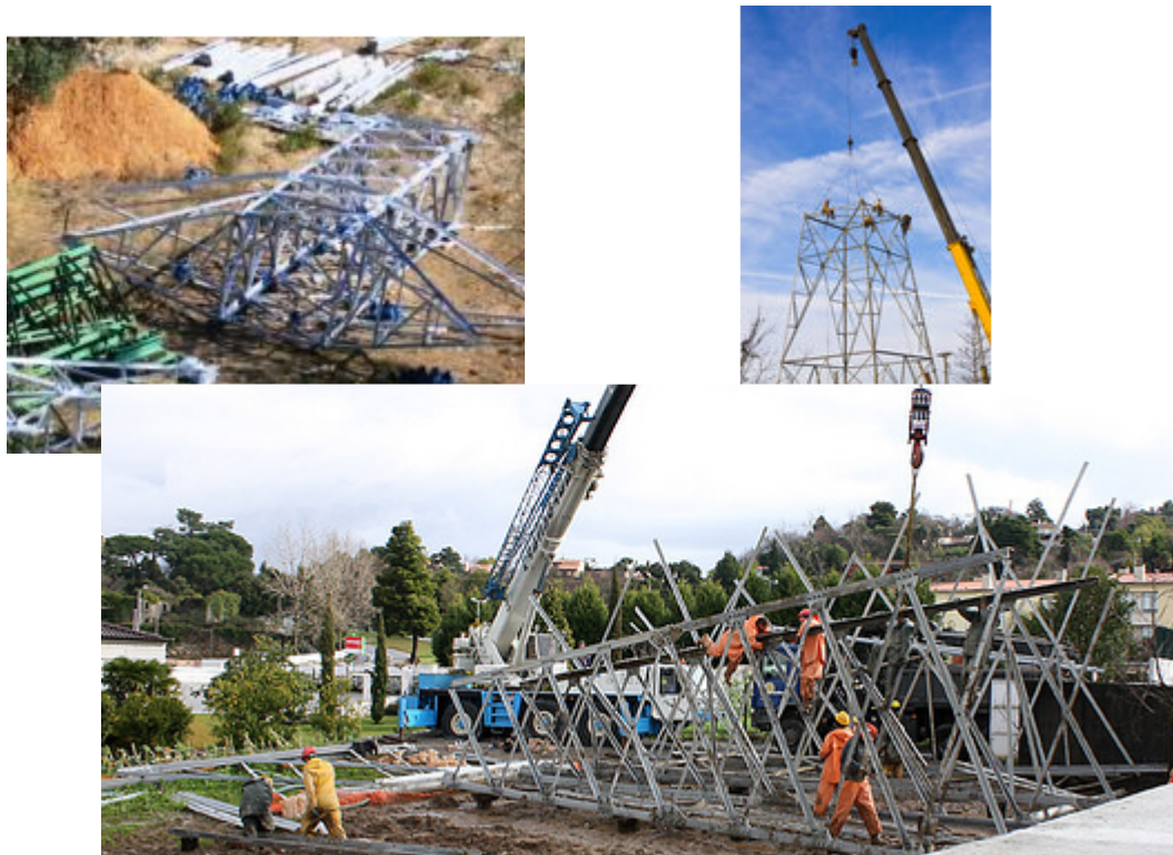
Figura 5.17 – Montagem e levantamento dos apoios [34];
