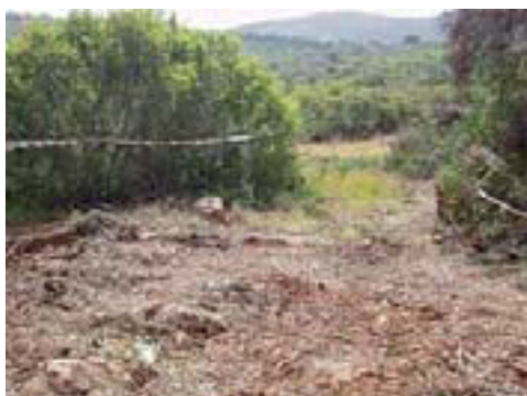
Figura 5.13 – Sinalização dos acessos para a montagem dos apoios [29];
