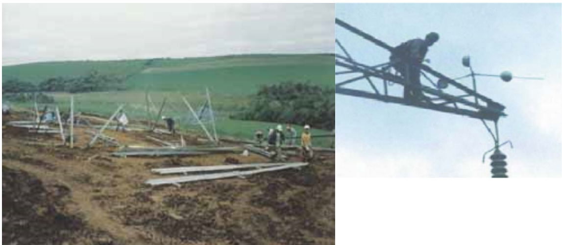
Figura 5.1 – Fase de montagem de uma linha aérea [26];
