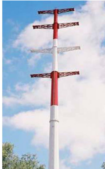
Figura 5.6 - Exemplo de um apoio tubular em aço [29];
