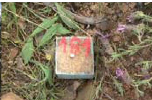
Figura 5.16 – Marcação de cabouco com recurso à topografia [29];
