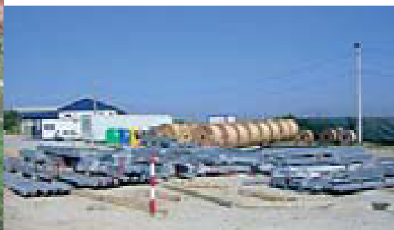
Figura 5.12 – Instalação dos estaleiros [29];
