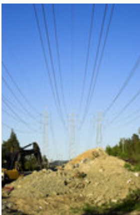
Figura 5.9 - Escavações para abertura de caboucos [33];
