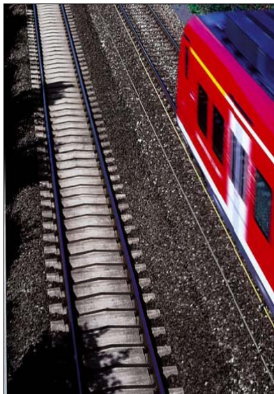
Fig. 13 Exemple de voie constituée de traverses BBS sur la ligne Homburg-Bexbach (workshop track for high speed railways, 2006)
