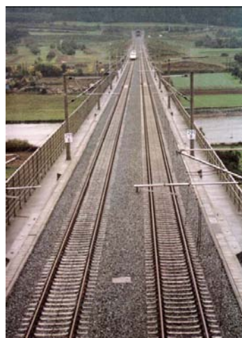
Fig. 21 voie avec ballast en Allemagne (workshop track for high speed railways, 2006)
