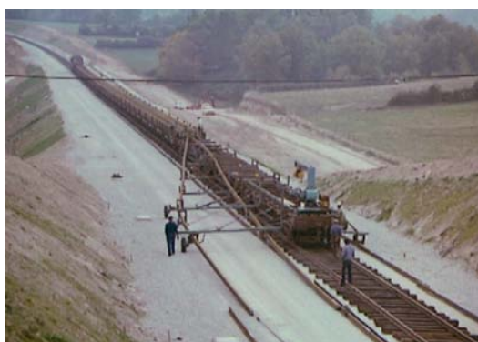
Fig. 4 Pose de rails LRS (La voie ferrée, Alias Jean, Gentil, P. , 1984)
