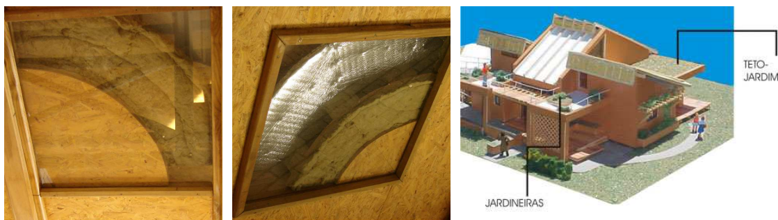
Figura 4.14: Da esquerda para a direita: pormenor da constituição de uma parede; pormenor da constituição da cobertura; esquema da localização do telhado-jardim [84],[81].
