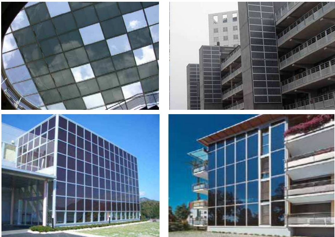
Figura 2.27: Exemplos de BIPV em fachadas e coberturas [29].
