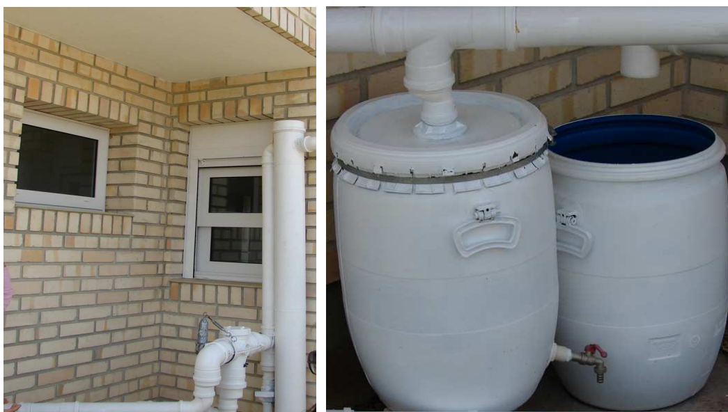
Figura 4.21: Pormenores do sistema de descarga de água de primeiras chuvas [84].
