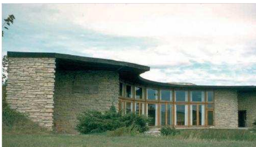
Figura 2.81: Exemplo de pala horizontal infinita, edifício Jacobs II. Verifica-se a continuidade da pala ao longo de toda a fachada [19].
