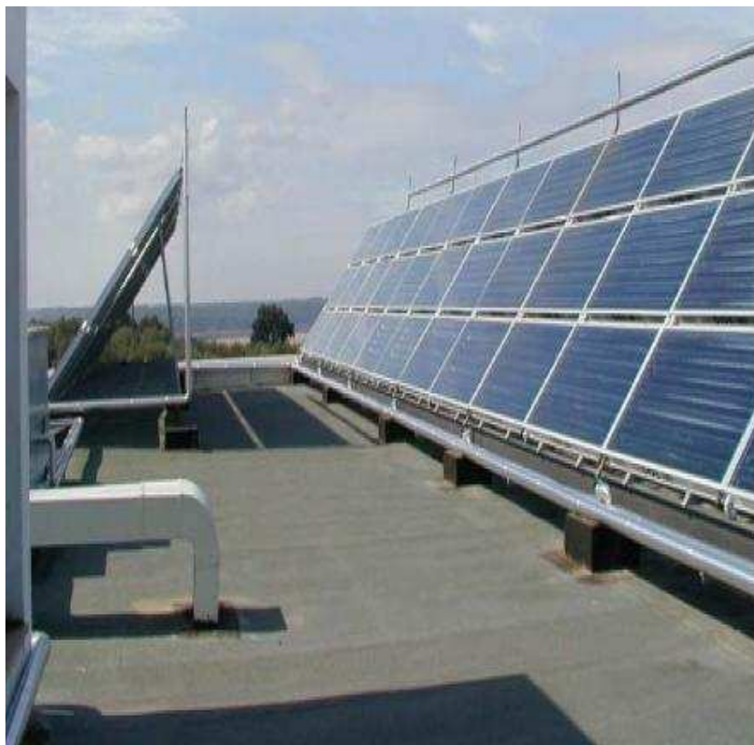
Figura 2.44: Integração de colectores solares em edifícios [44].
