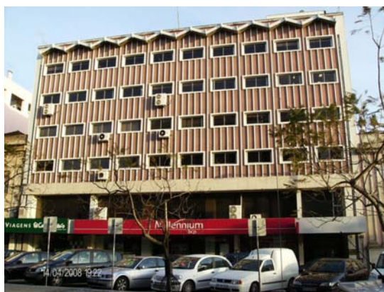
Figura 5.4 – Edifício de betão armado em estudo.
