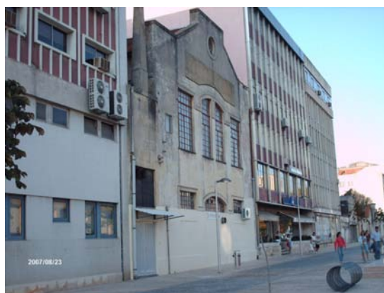
Figura 4.38 – Edifício de alvenaria entre dois edifícios de betão armado.
