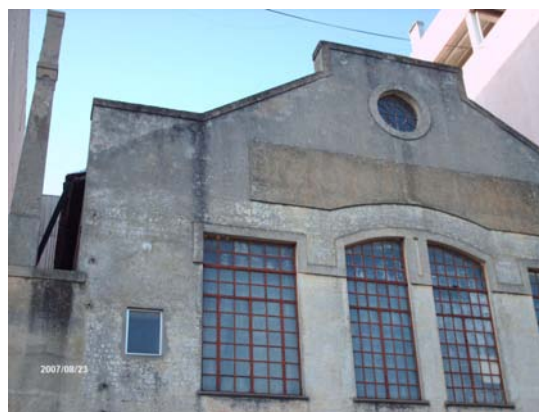
Figura 4.22 – Pormenor da chaminé.
