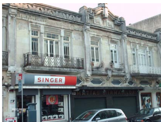
Figura 4.27 – Edifício nº10 (vista frontal).
