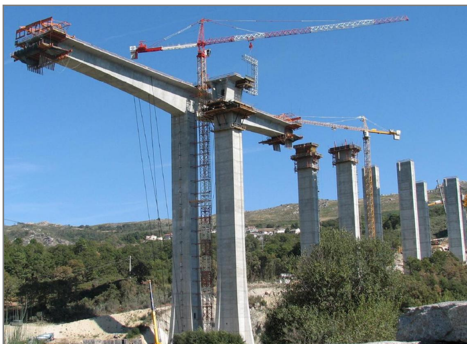
Fig. 4 – Construção por avanços sucessivos – tramos centrais do Viaduto de Vila Pouca de Aguiar [5]
