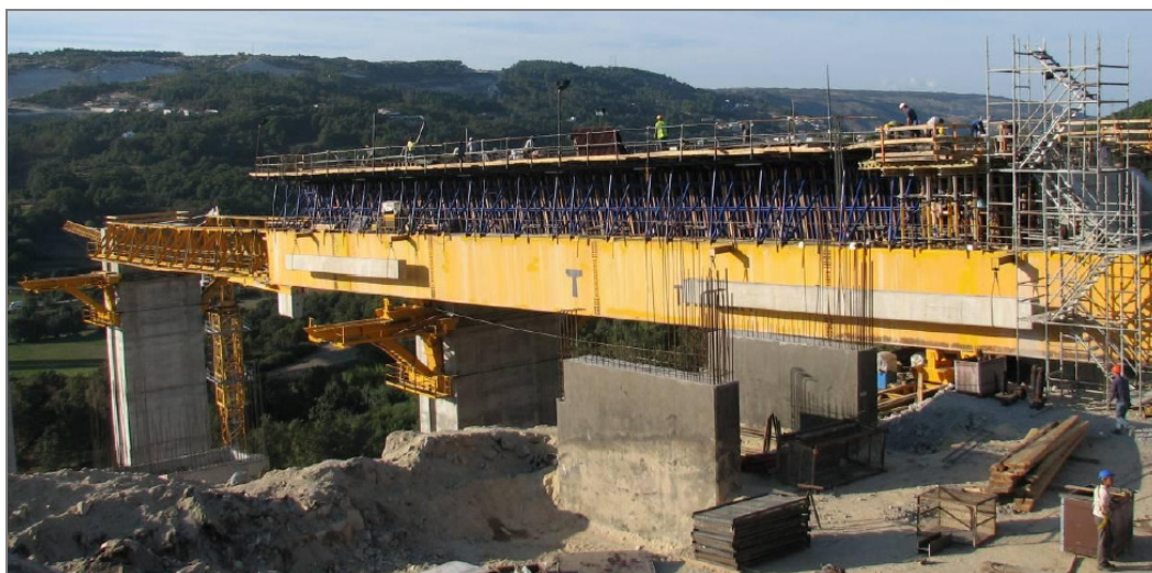
Fig. 7 – Construção com cimbra autolançável inferior – Viaduto de Vila Pouca de Aguiar [5]
