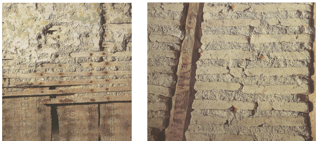
Figura 2.6 – Taipa de fasquio e taipa de rodízio respectivamente.
