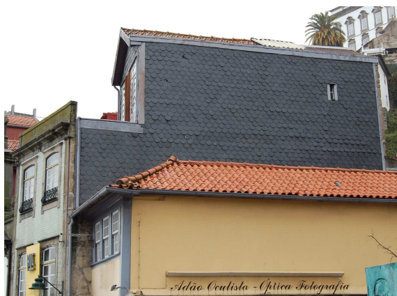
Figura 2.11 – Parede exterior de meação revestida a soletos de ardósia.
