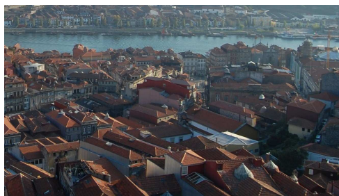
Figura 2.15 – Telhados em telha cerâmica existentes no centro histórico do Porto.
