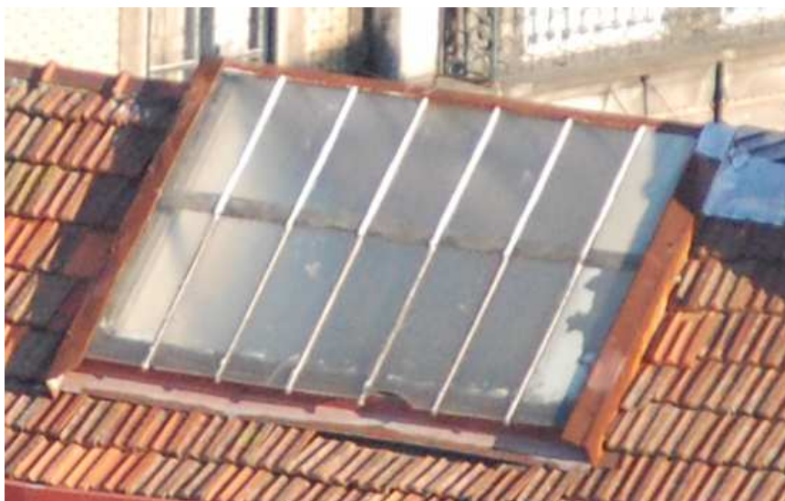
Figura 3.4 – Clarabóia Simples Plana de duas águas (foto da autora)
