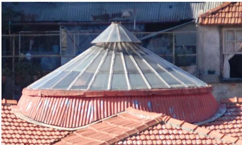
Figura 3.5 – Clarabóia Simples Estrutural por gomos (foto da autora)
