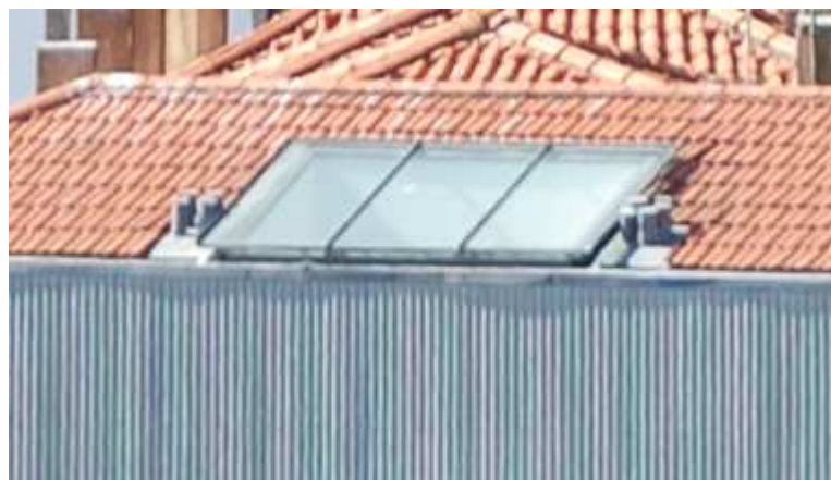
Figura 3.3 – Clarabóia Simples Plana de uma água
