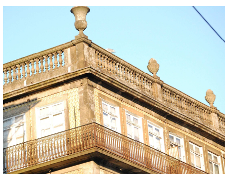
Figura 2.13 – Platibanda com balaústres, em pedra com ornamentos na parte superior.
