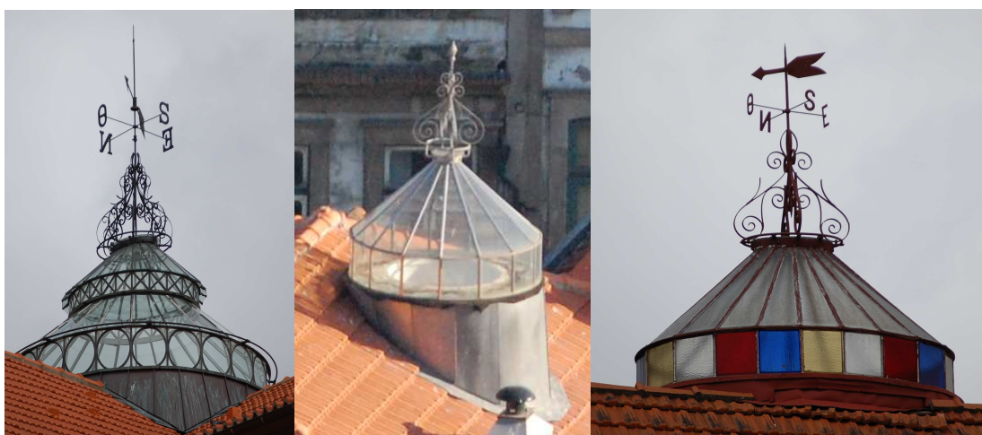
Figura 3.7 – Clarabóias Complexas Estruturais Tridimensionais (fotos da autora)
