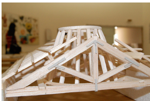
Figura 2.10 – Maqueta da estrutura principal de uma clarabóia. (foto da autora – maqueta na FAUP)
