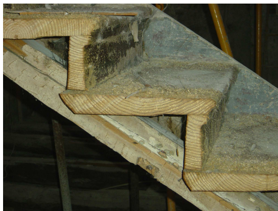
Figura 2.5 – Escadas em madeira.
