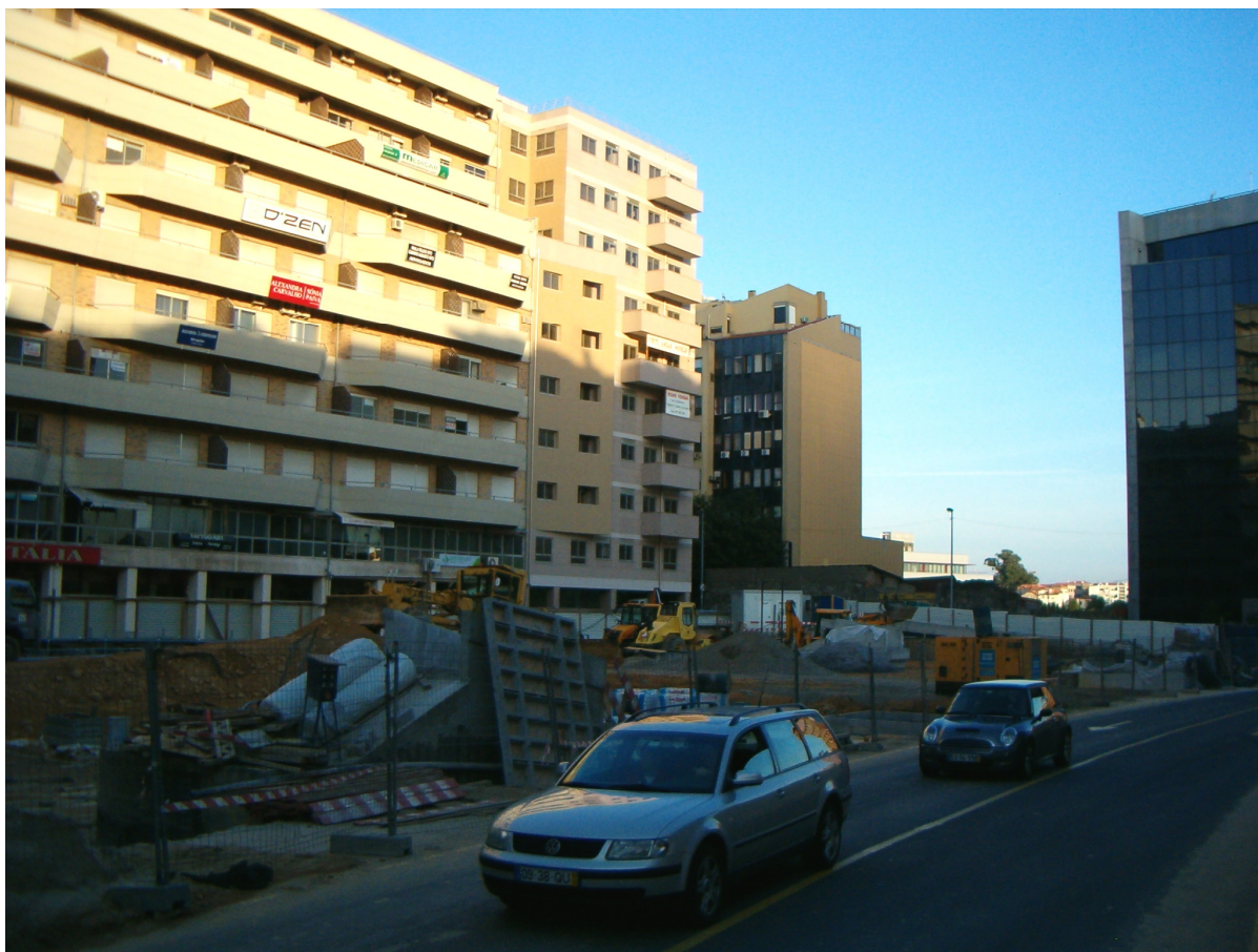
Fig. 1 – Aspecto geral do estaleiro da obra “Construção do Parque de Estacionamento Subterrâneo em frente ao Edifício Parque Itália” (Rua Júlio Dinis – Porto).
