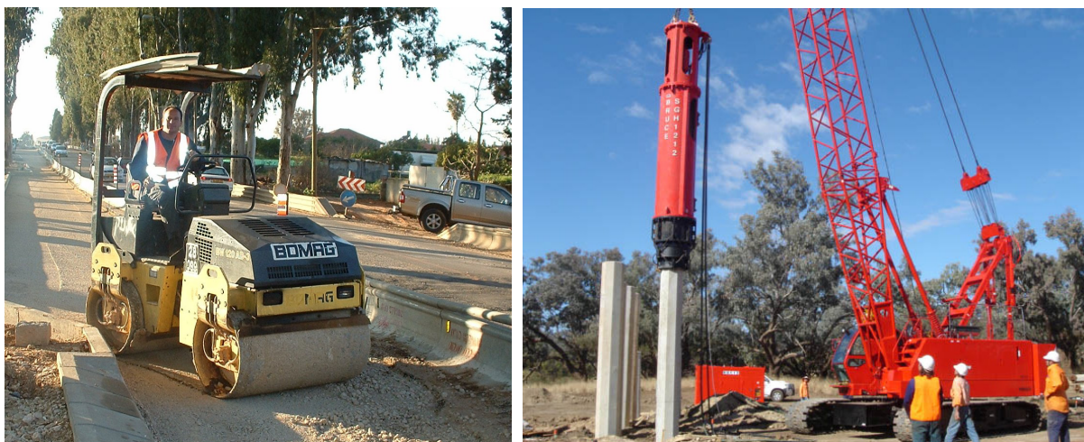
Fig.19 (esq.) e 20 (dir.) – Equipamento de construção civil: Cilindro compactador (lado esquerdo) e Bate-estacas hidráulico. (lado direito). [25]
