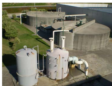
Figura 3.1.2: Coluna de adsorção em filtros de carvão activado.
