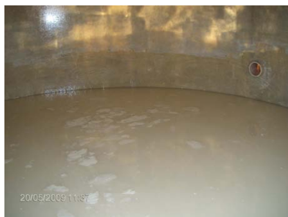
Figura 4.11: Base da torre nº 2.
