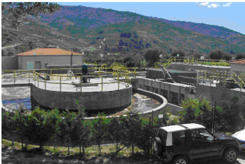
Fig.3.2 – Vista geral da ETAR de Cambres.
