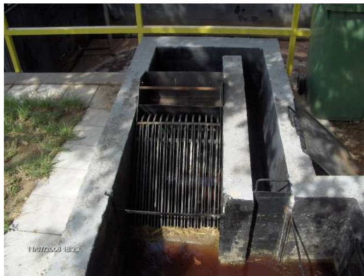
Fig.4.5 – Dificuldade na retenção de sólidos na etapa da gradagem.
