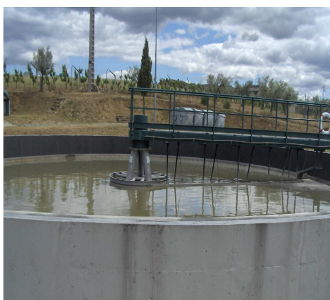
Fig.6.12 – Decantador secundário em estado normal
