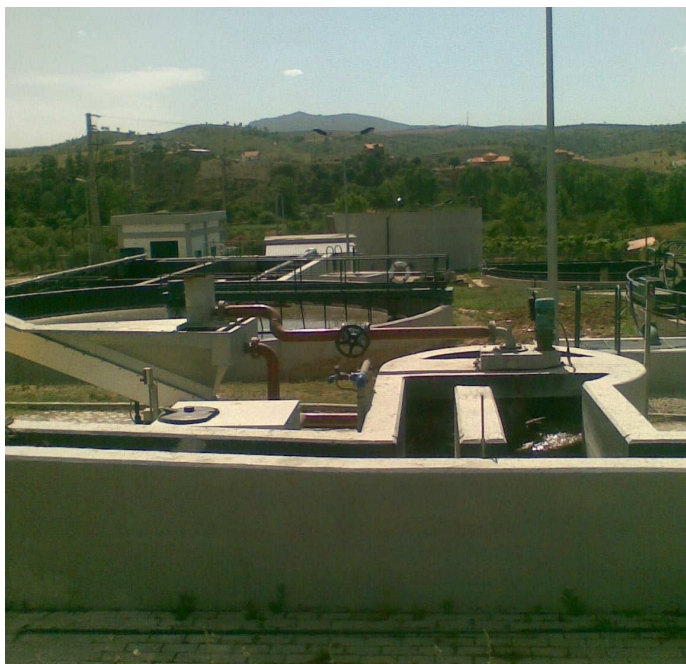
Fig. 6.2 – Vista geral da ETAR de Mirandela.
