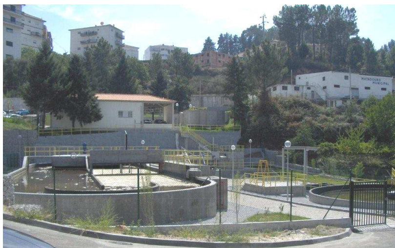
Fig.4.2 – Vista geral da ETAR de Resende-Mirão.
