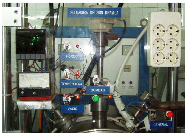
Figura 46: Pormenor do controlador de temperatura e de vácuo
