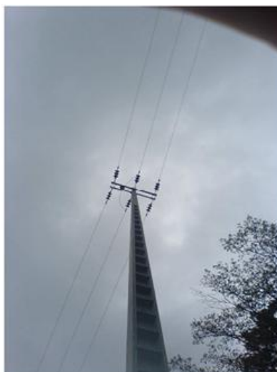
Figura 3.6 - Armação tipo esteira horizontal (HRSFC).
