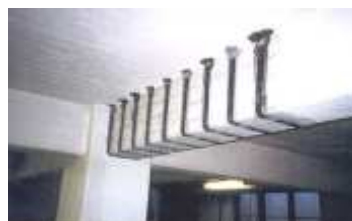
Fig. 4.12 – Reforço de viga com laminados em forma de L de F.R.P.
