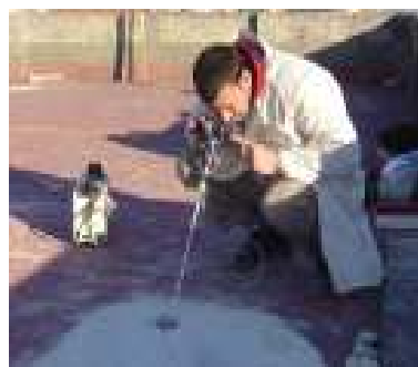
Fig. 3.21 – Observação do interior de um pavimento [6]
