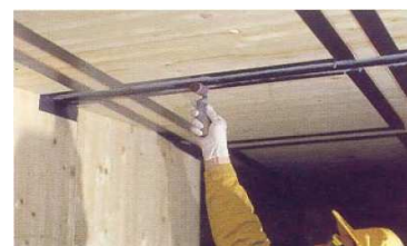
Fig. 4.13 – Reforço de laje com laminados de F.R.P.
