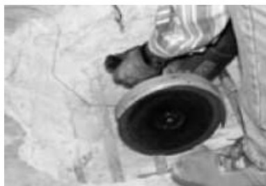
Fig. 3.6 – Corte de um varão de uma viga
