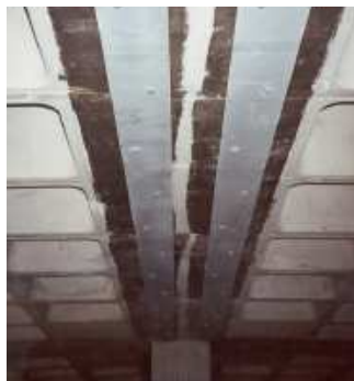
Fig. 6.39 – Reforço de viga nervura por colagem de chapas metálicas
