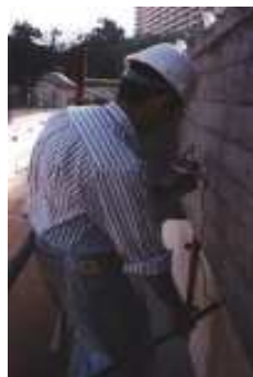
Fig. 3.12 – Ensaio da detecção de corrosão numa parede de betão armado [6]
