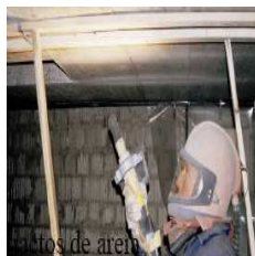
Fig. 4.15 – Preparação da superfície do betão por jacto de areia
