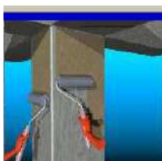
Fig. 4.17 – Aplicação de primário epóxido de forma a aumentar a resistência superficial [17]
