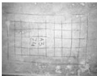
Fig. 3.8 – Mapeamento das armaduras numa laje [6]
