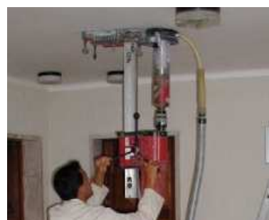
Fig. 3.2 – Extracção de carote em laje [6]
