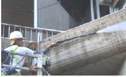
Fig. 6.40 – Remoção de sujidades da superfície de betão com auxílio de jacto de água
