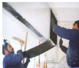
Fig. 6.51 – Reforço de viga com colagem de laminados e tecidos de CFRP [7]
