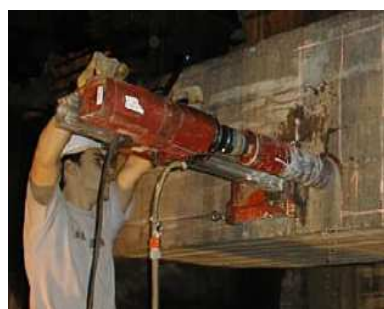
Fig. 3.1 – Extracção de carote em viga [6]
