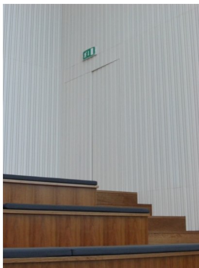
Fig.6.6 – Saída de evacuação do auditório (Saída 10).
