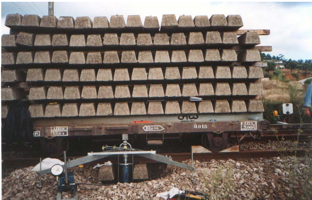
Figura 2.4 - Ensaio de carga em placa utilizando como reacção do macaco hidráulico um vagão carregado com travessas de betão (Fortunato, 2005)
