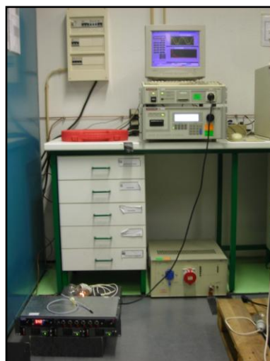
Figura 6.9 - Montagem IEP para o Ensaio de Emissão Conduzida - Harmónicas de Corrente. EFAPOWER CIB S 48V/40A c/microPSM Rack 19'' 2U.
