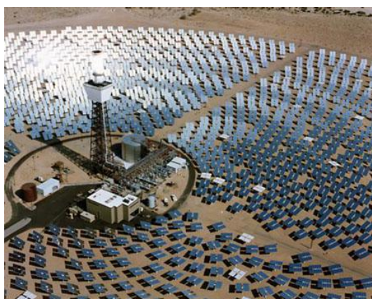
Figura 3.22 - Central CSP Solar Two (Estados Unidos)
