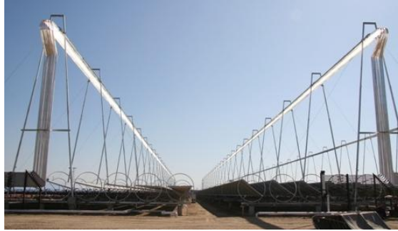
Figura 2.31 - Central de 5 MWe do tipo LFR, California, USA [26]
