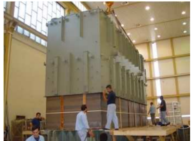
Figura 9 - Colocação da Cuba Superior
