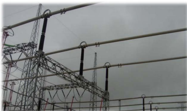
Figura 3 - Barramento duplo em tubo trifásico (esquerda), símbolo unifilar (direita)
