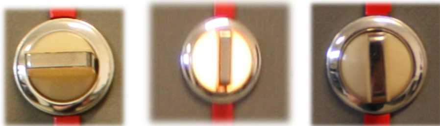
Figura 10 - Sequencia de posições de um botão de um seccionador para a manobra de fecho
