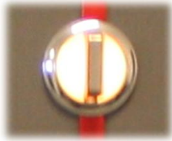
Figura 9 - Botão de um seccionador em discordância.
