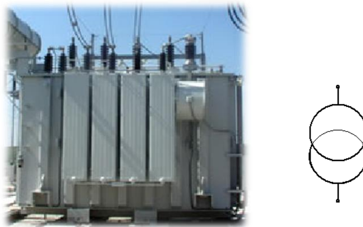
Figura 1 - Transformador de potência (esquerda), símbolo (direita)
