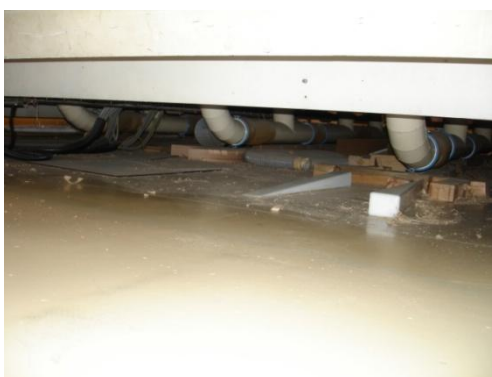
Figura 59 – Local do chão da fábrica (antes).
