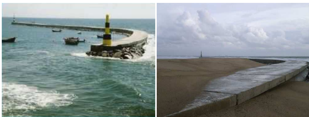
Fig.2.5 – Quebramar destacado da Aguda no final da construção e após formação do tómbolo (Instituto da Água, 2002; www.panoramio.com ).
