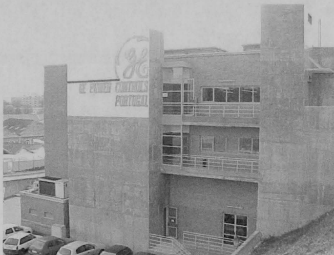
Figura 1 – Edifício da GE Power Controls Portugal
