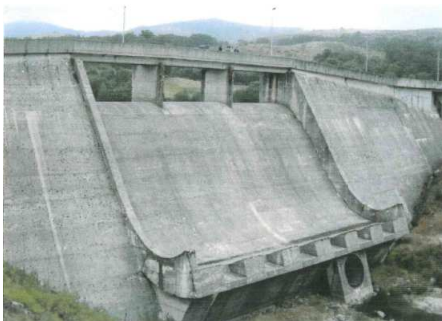
Fig. 5.6: Descarregador de cheias. Vista geral de jusante. Fonte: EDP - Gestão da Produção de Energia, S.A. (2006a).
