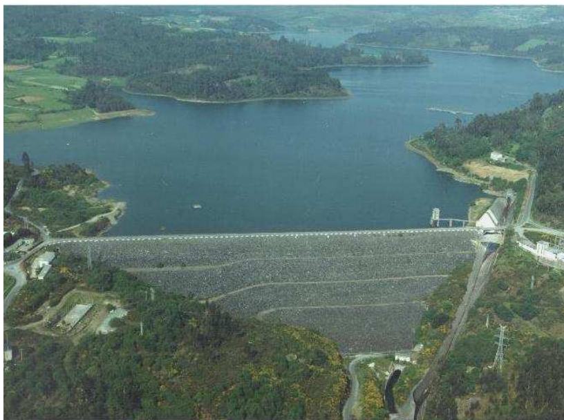
Fig. 3.22: Barragem de Portodemouros. Vista Geral. Fonte: Blogspot (2010)
