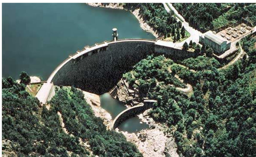
Fig. 5.27: Barragem de Salamonde. Vista geral. Fonte: CNPGB (2010).
