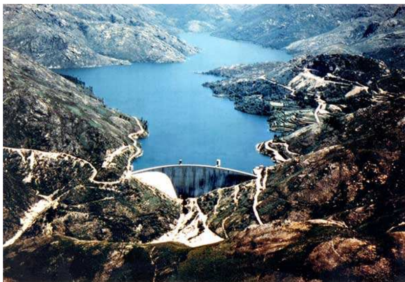
Fig. 5.41: Barragem de Vilarinho das Furnas. Vista geral. Fonte: CNPGB (2010)
