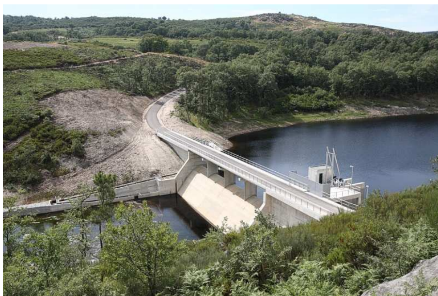
Fig. 3.17: Barragem de Canedo. Fonte: Câmara Municipal de Boticas (2010).
