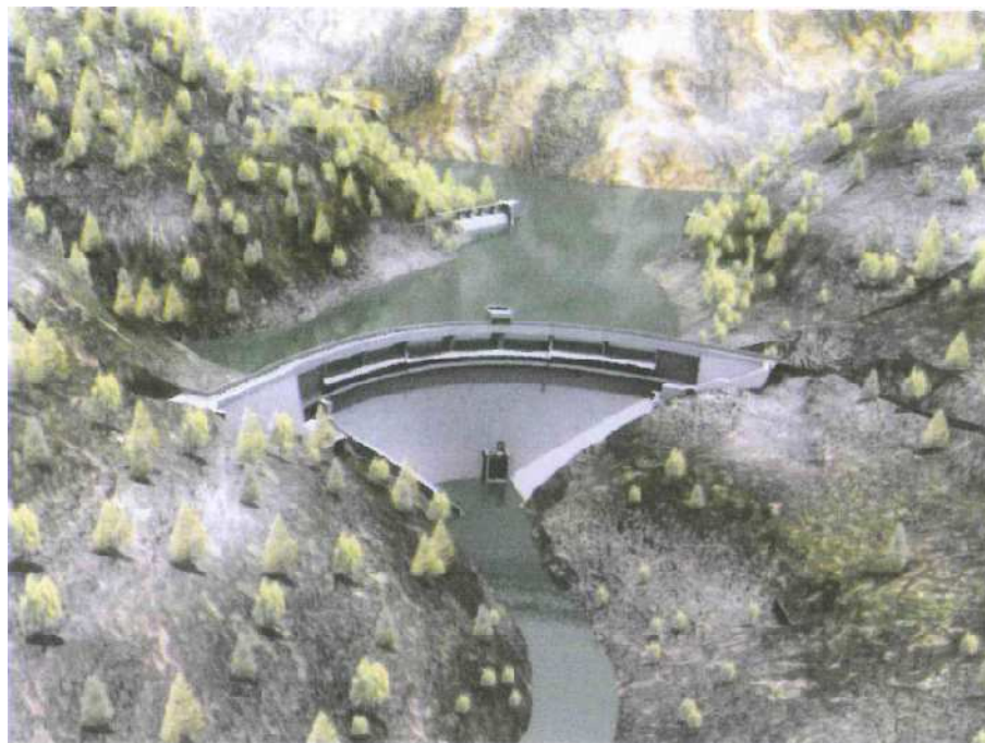
Fig. 3.9: Nova barragem do Alto Ceira. Antevisão. Fonte: EDP – Gestão da Produção de Energia, S.A. (2007).
