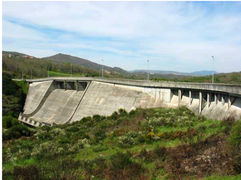
Fig. 5.3: Barragem do Alto Cávado. Vista geral. Fonte: CNPGB (2010)
