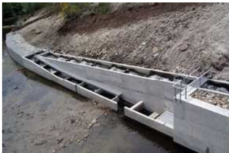
Fig. 3.18: Barragem de Canedo. Passagem de peixes da. Fonte: Aqualogus.
