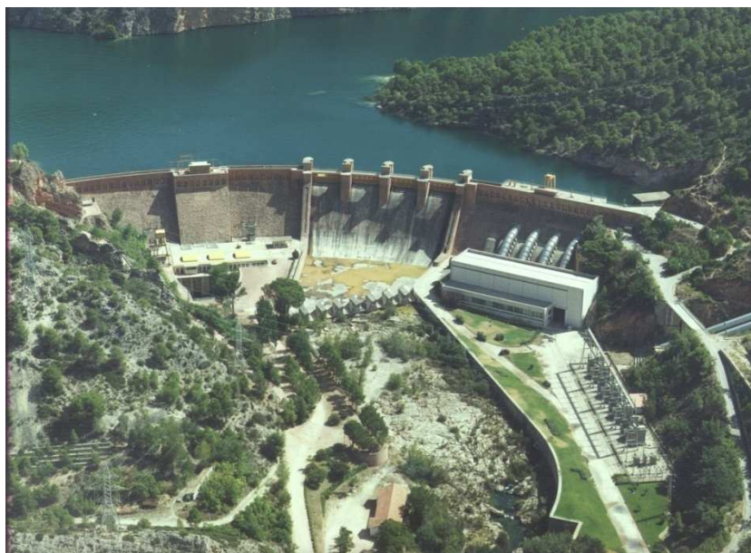
Fig. 3.24: Barragem de Bolarque. Vista geral Fonte: Seprem (2010b).
