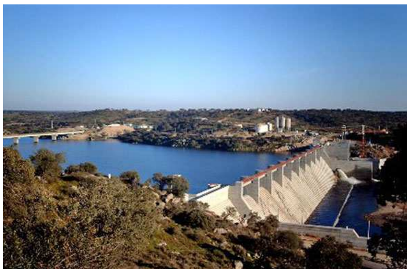
Fig. 3.1: Barragem de Pedrógão. Vista geral. Fonte: CNPGB (2010).
