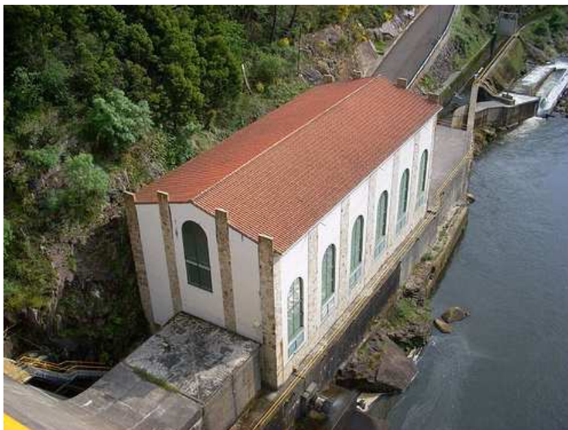
Fig. 3.21: Barragem de Barrié de la Maza. Central mini-hídrica Tambre III. Fonte: Flickr (2010)
