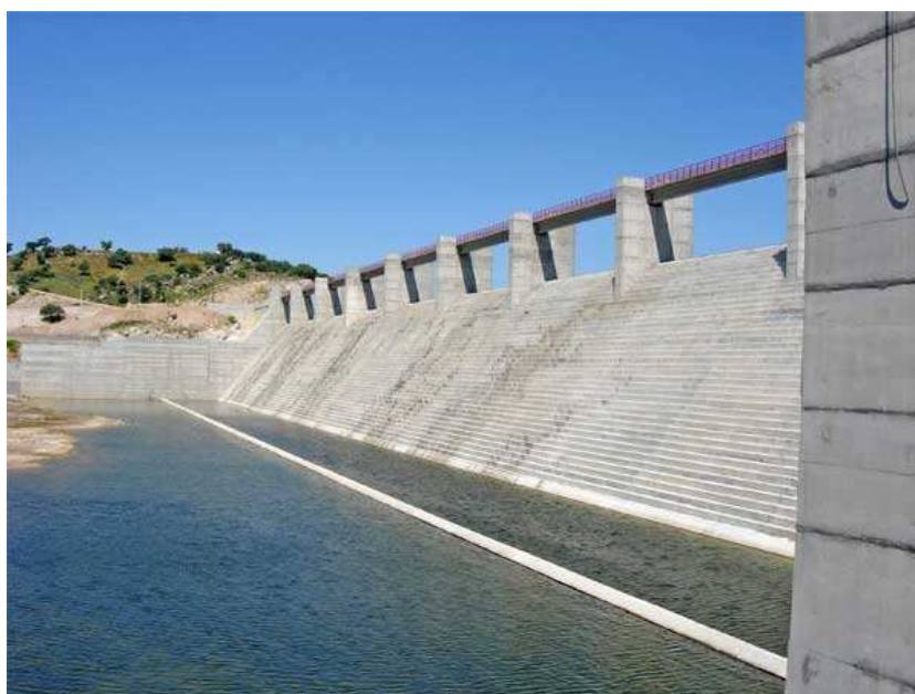
Fig. 3.3: Barragem de Pedrógão. Vista de jusante para o descarregador de cheias. Fonte: CNPGB (2010).
