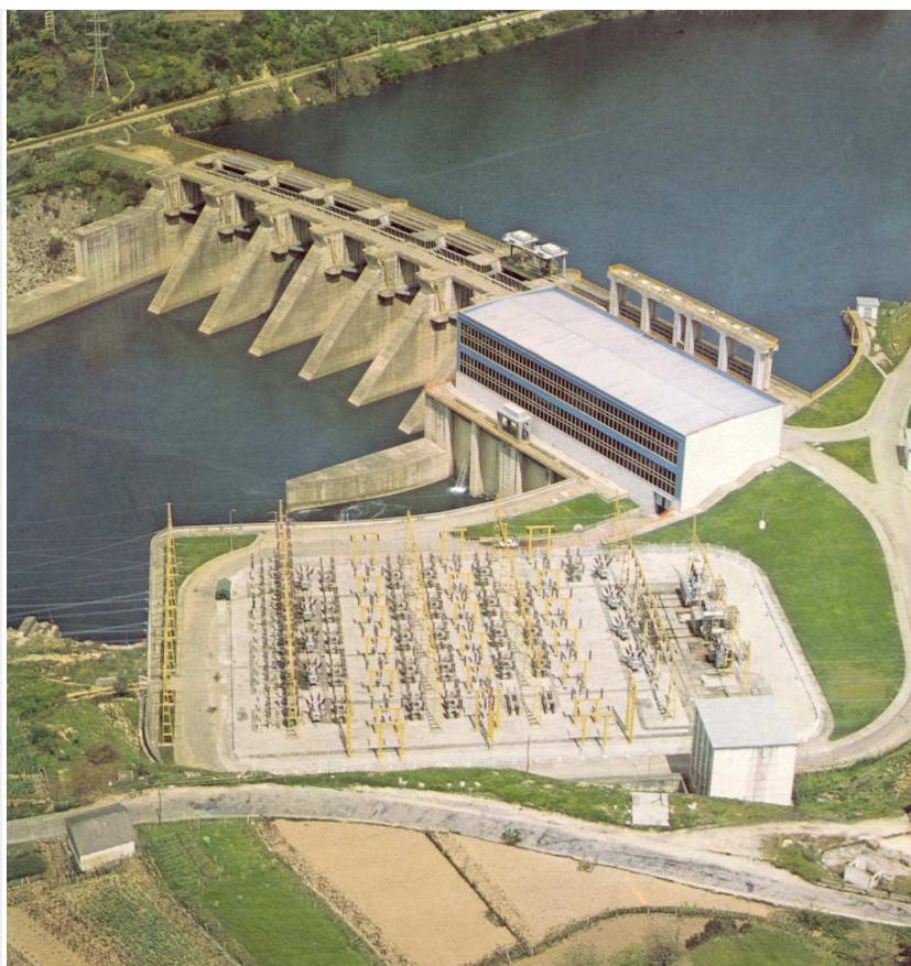
Fig. 3.23: Barragem da Frieira. Vista geral. Fonte: Seprem (2010a)
