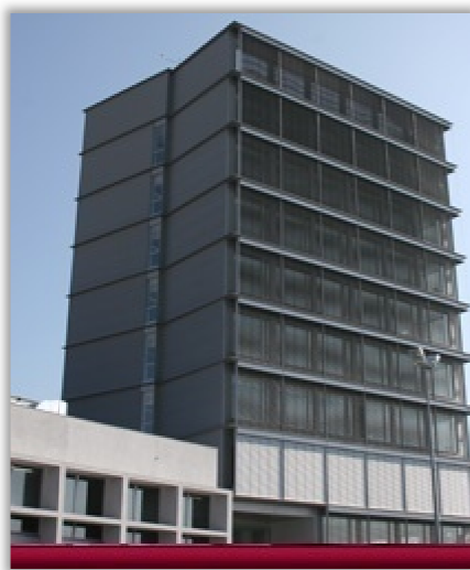
Figura 1 – Edifício do INEGI (entrada principal).
