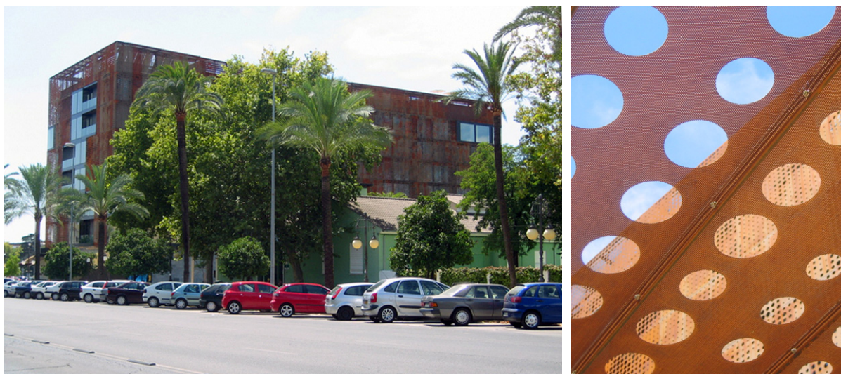
Figura 1: Edifício em Córdoba com fachadas compostas por chapas de aço microperfuradas e panos de vidro justapostos (arquitectura: Justo Isasi e Alfonso Casares)
