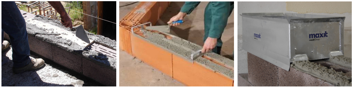
Figura 46: Assentamento com junta descontinua e utensílios próprios para a sua execução (fontes: Porotherm [95], Maxit )
