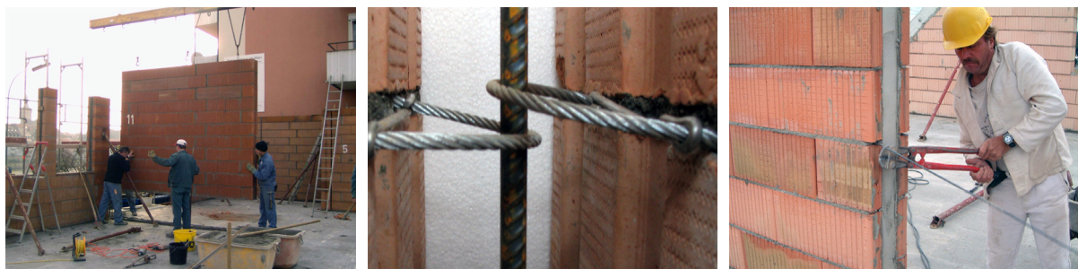
Figura 69: Montagem de painéis prefabricados em obra (fonte: Franken Ziegel [76])
