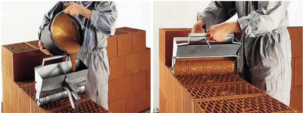
Figura 43: Aplicação de argamassa cola em juntas delgadas (fonte: Zeller Poroton [96])
