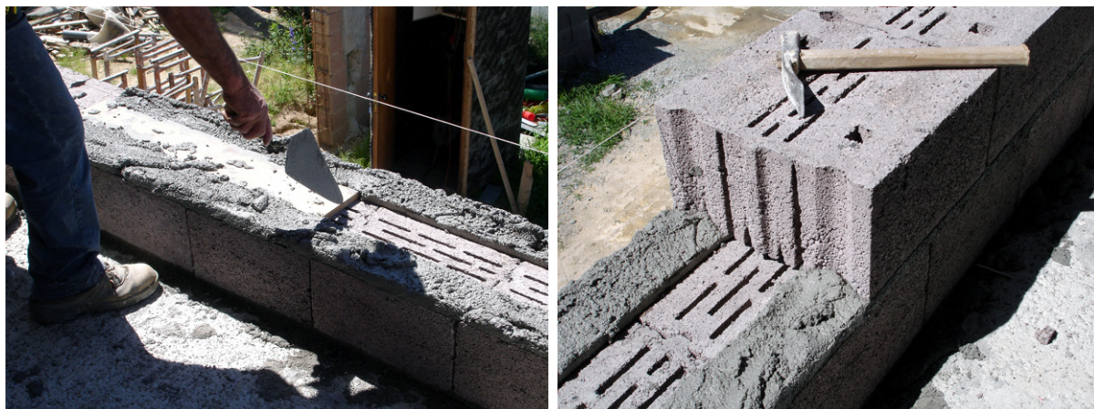
Figura 42: Junta de assentamento descontinua em alvenaria com blocos “Conforto”
