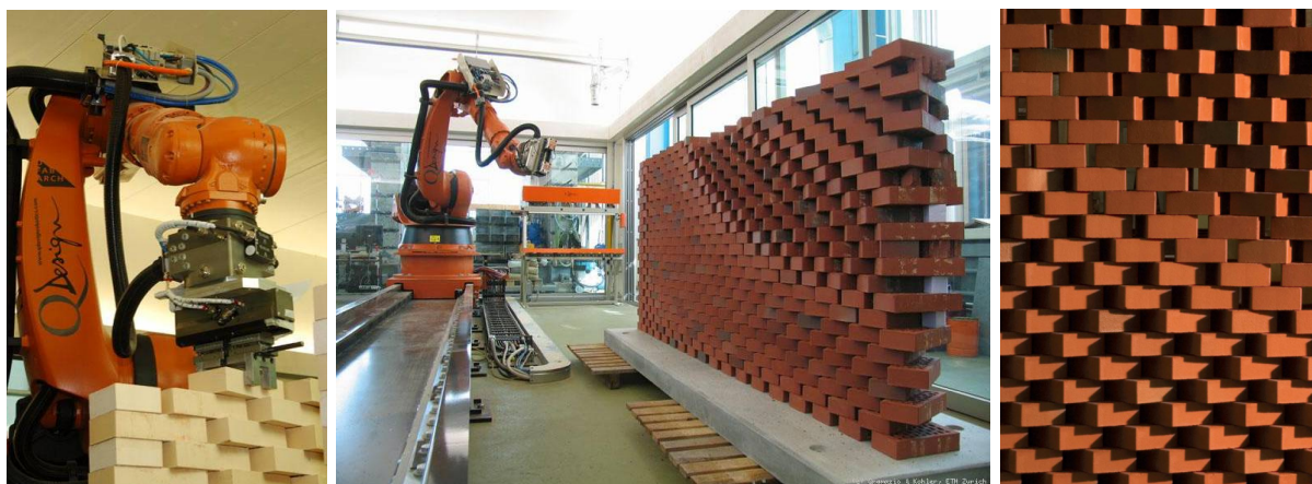
Figura 64: Produção robotizada de painéis de alvenaria (fonte: Architecture and Digital Fabrication laboratory, ETH Zürich [75])
