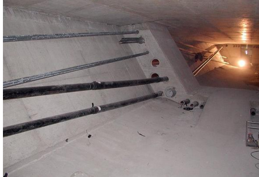
Fig. 3.10. – Cabos de pré-esforço exteriores [20].
