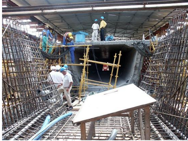
Fig. 2.14. – Parque de fabricação num encontro [12].
