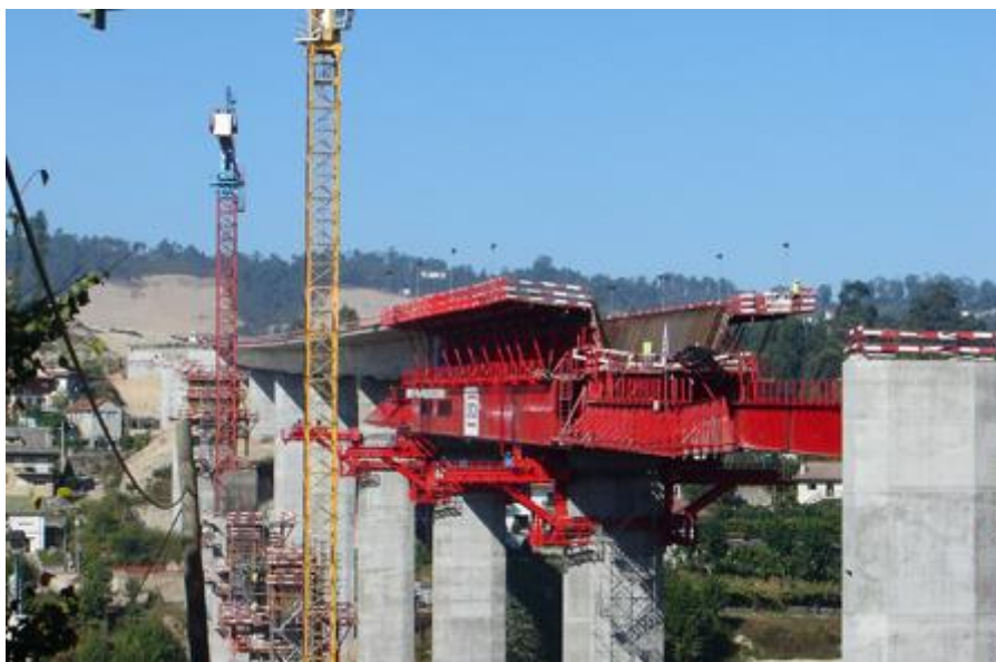
Fig. 2.11. – Cimbra autolançável inferior [10].
