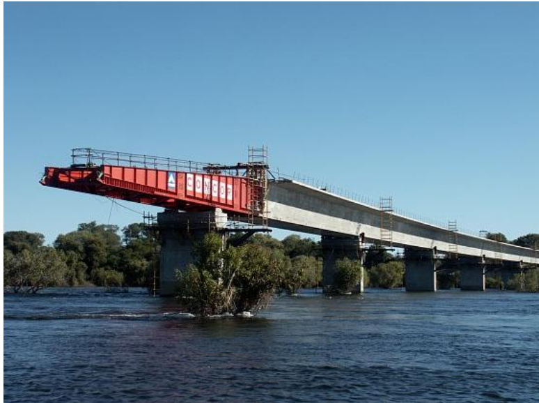
Fig. 2.15. – Viga metálica dianteira (“avant-bec”) [12].
