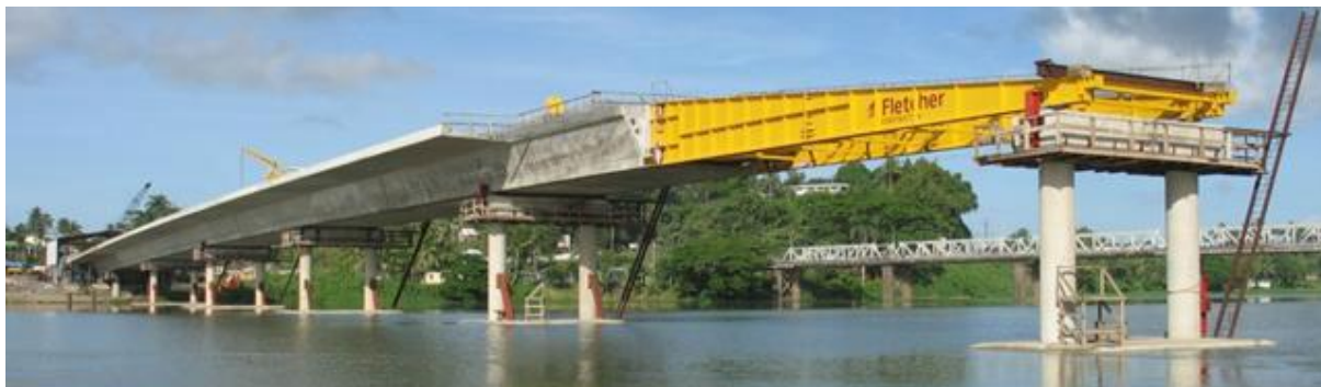
Fig. 2.13. – Deslocamentos sucessivos [11].
