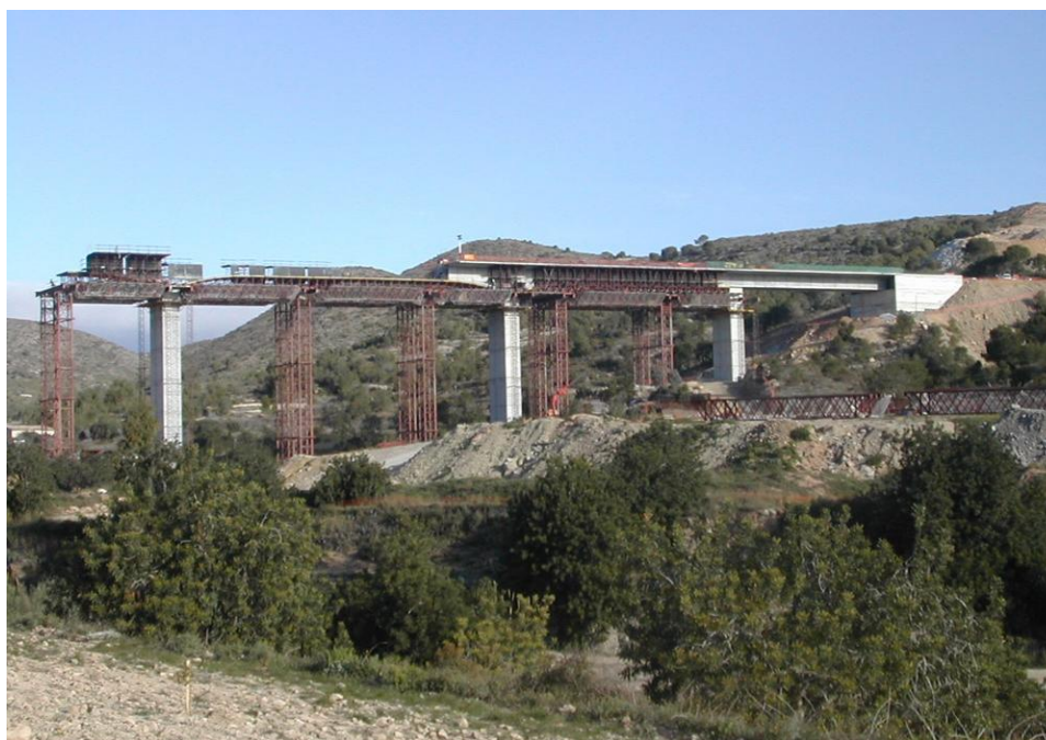
Fig. 2.4. – Construção tramo a tramo com cimbre fixo [5].
