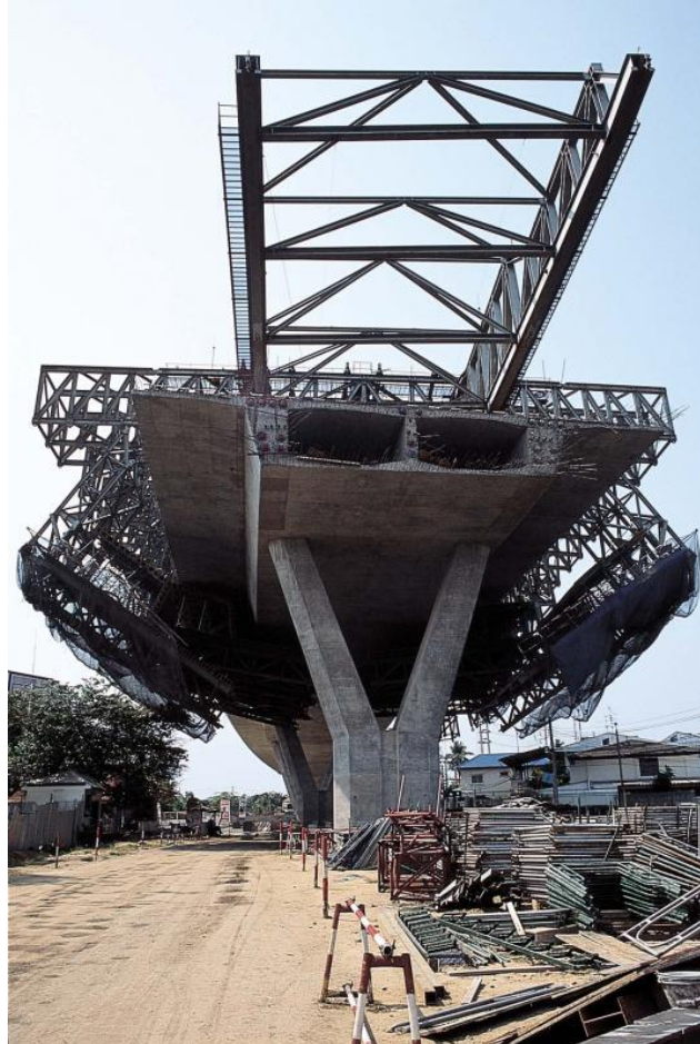
Fig. 2.10. – Cimbra autolançável superior [9].
