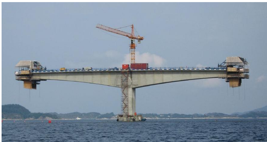
Fig. 2.17. – Método dos avanços sucessivos [14].
