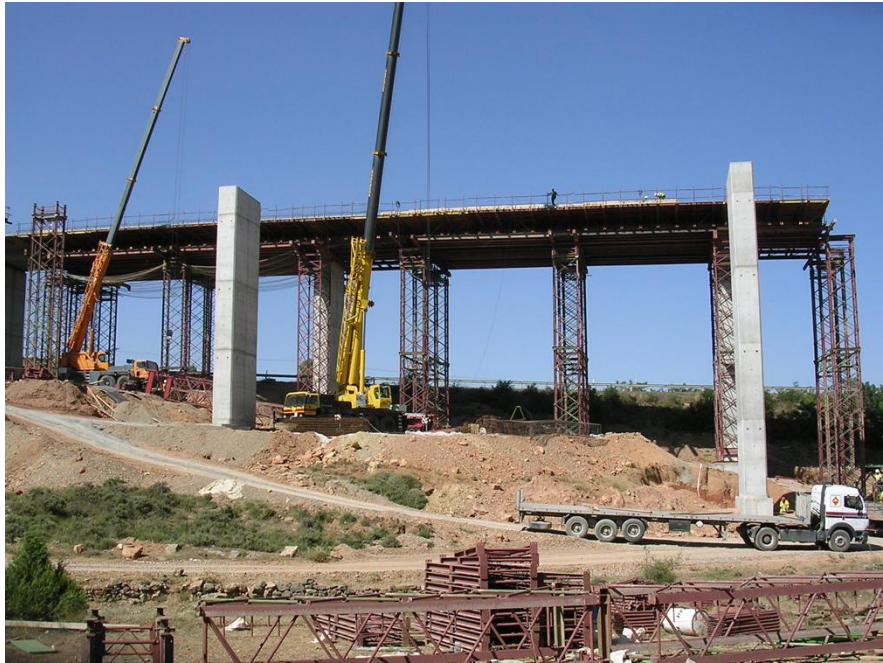
Fig. 2.2. – Cimbra fixo com vigas e montantes [5].
