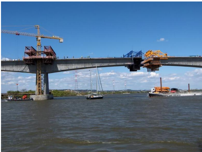
Fig. 2.18. – Carros de avanço na extremidade das consolas [15].
