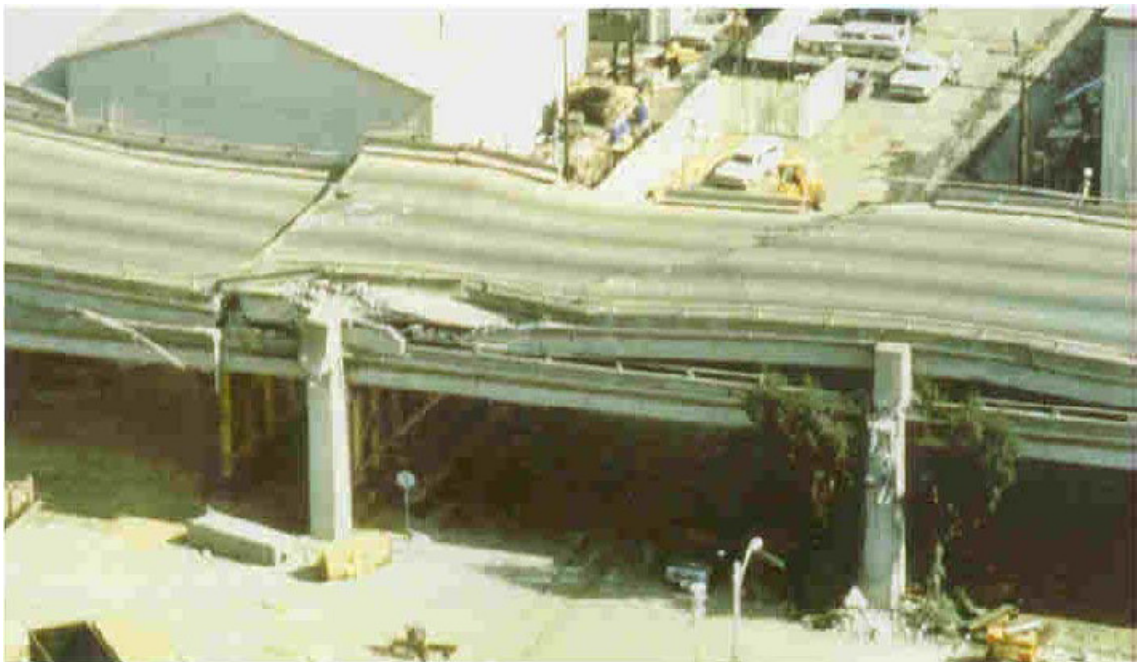
Figura 2.3 – Colapso do viaduto Cypress (Delgado, 2000)
