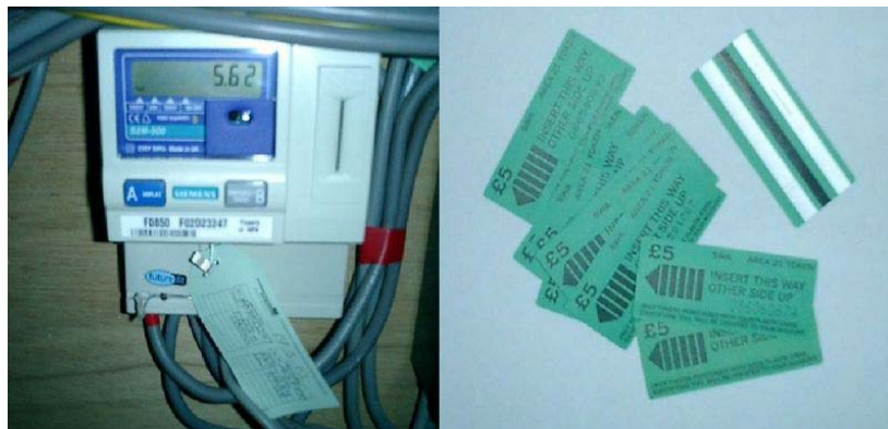
Figura 11 – Contador Pré-pagamento e respectivos cartões magnéticos.
