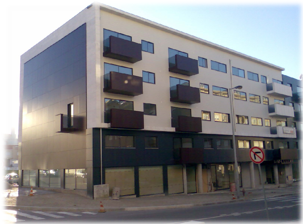
Fig.2.6 – Fachada principal do edifício (vista sudeste)
