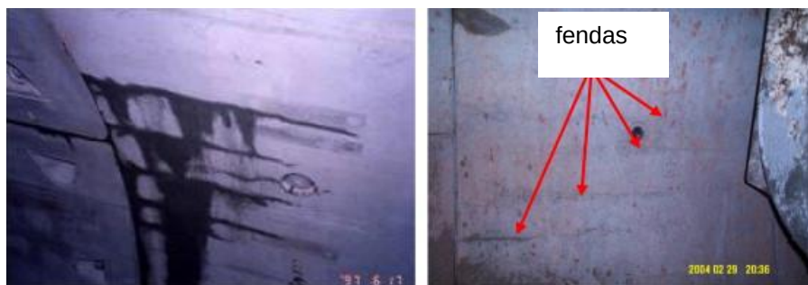
Fendilhação longitudinal
