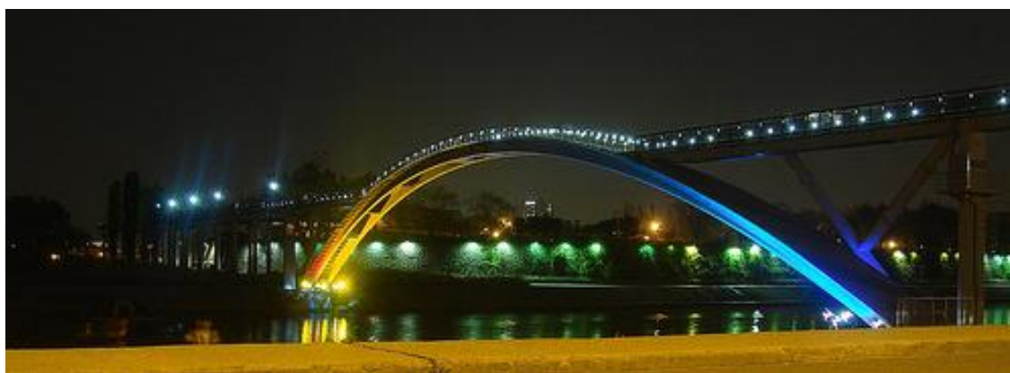
Fig. 2.1 - Ponte da Paz, Seoul. Ponte pedonal em betão de ultra elevado desempenho Ductal® (180-230 MPa). Vão: 120 m, largura do arco: 4,30m e espessura: 1,30 m. (Lafarge, 2008) Fonte: Flickr.
