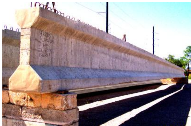
Fig. 2.4 Viga em I pré-esforçada - pré-tensão (Dhonde, Mo e Hsu, 2005)
