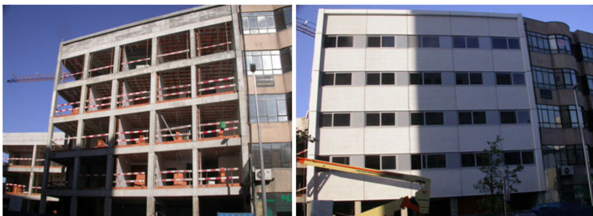
Fig. 2.4 - Edifício com fachadas em GRC, Maia
