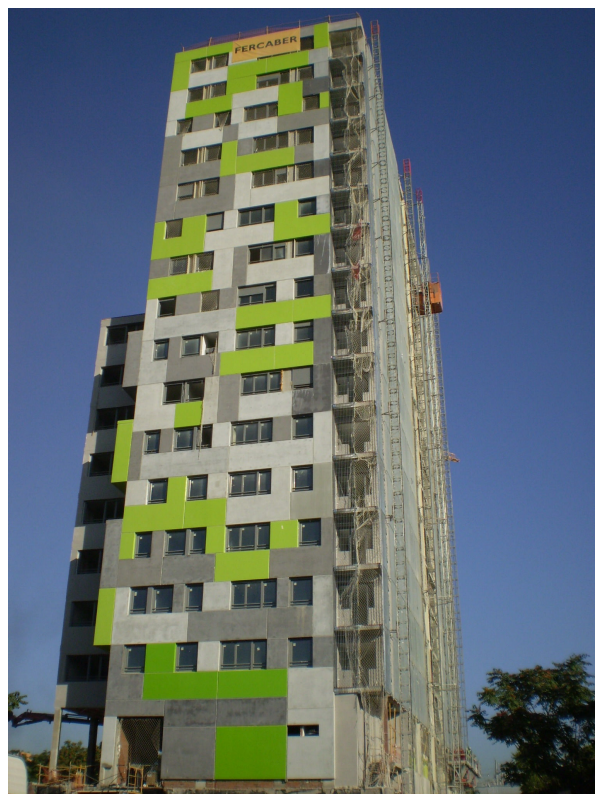
Fig. 2.3 - Edifício com fachadas em GRC, Madrid
