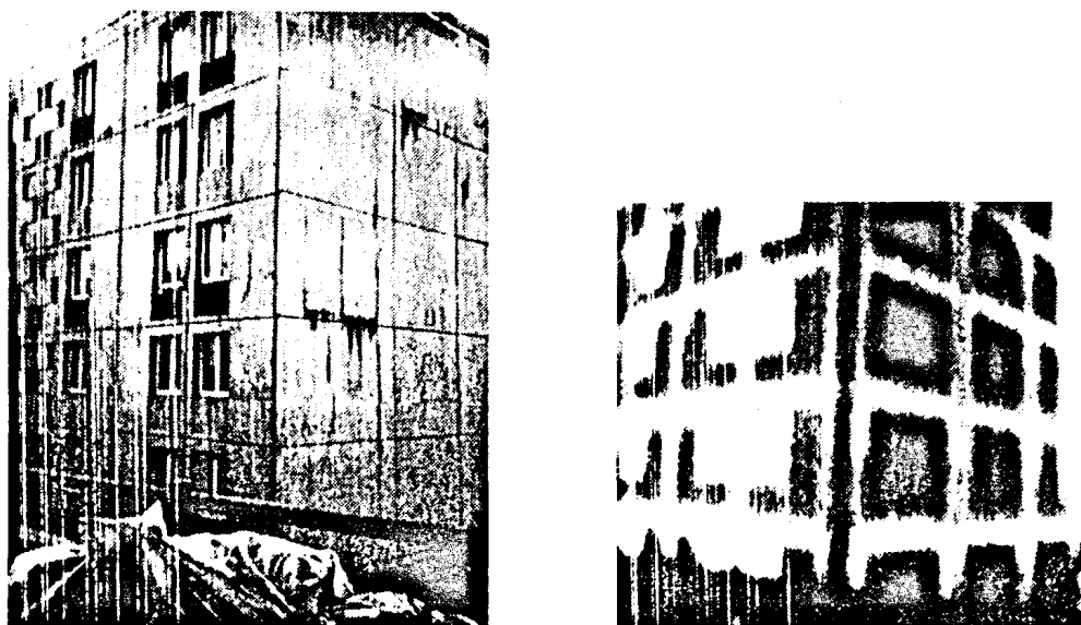
Fig. 5.2 - Fotografia e respectivo termograma de um edifício pré-fabricado [32]
