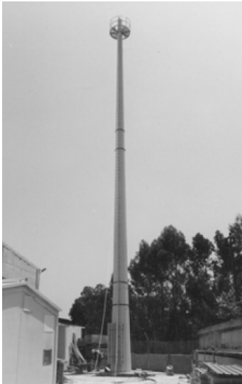
Fig. 2.5 - Torre de telecomunicações [6]
