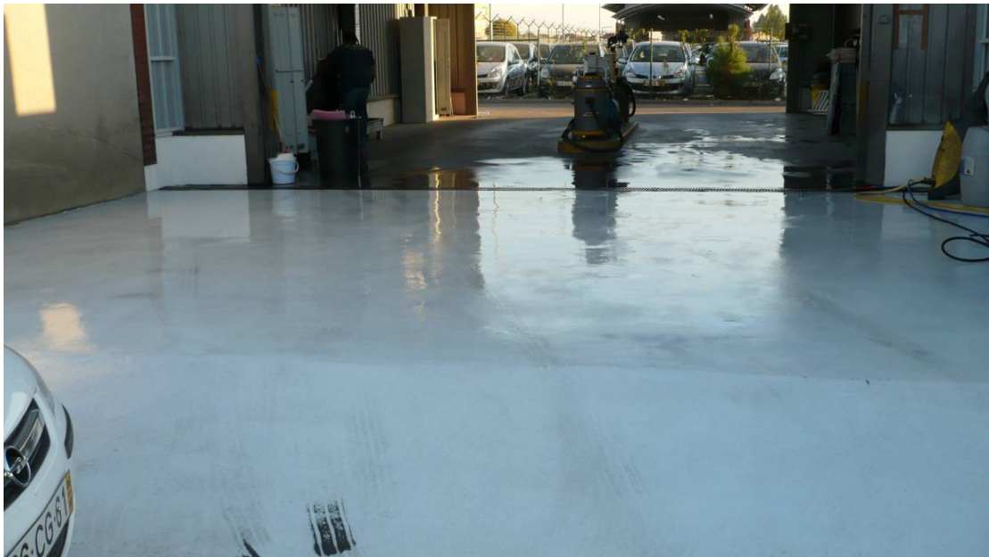
Fotografia 8 - Aspecto final das resinas na área de lavagem.
