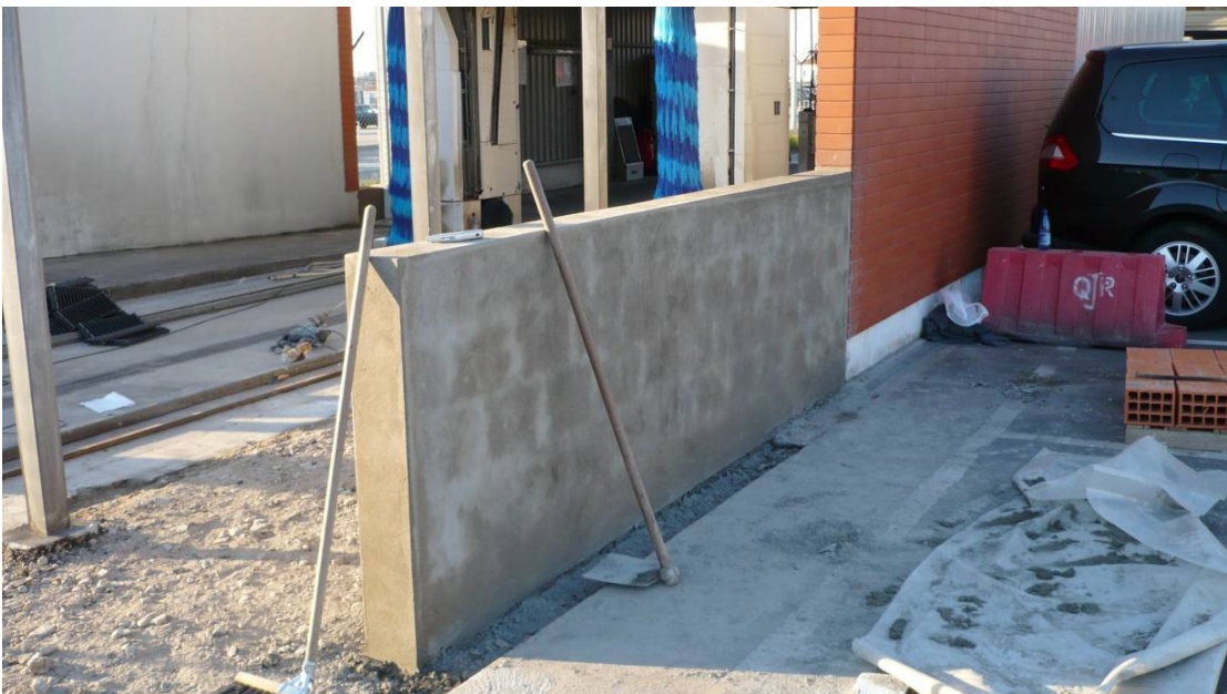
Fotografia 4 - Murete após ser rebocado.
