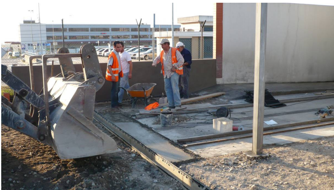
Fotografia 2 - Construção do canaleta.
