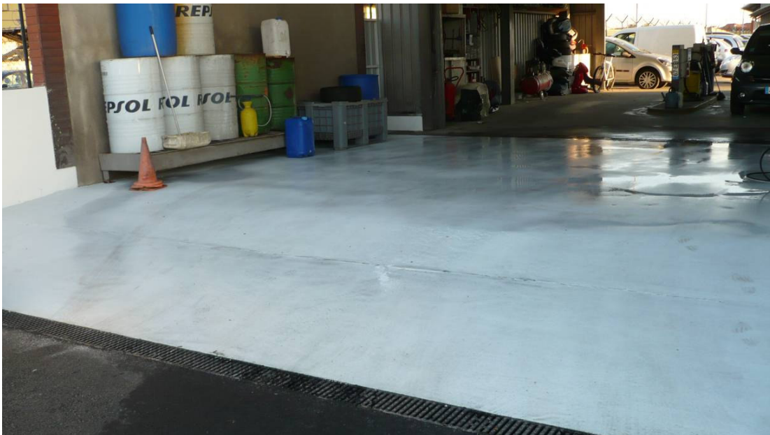
Fotografia 10 - Aspecto final de área de lavagem com rampa.
