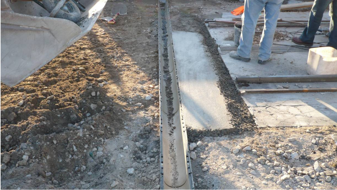
Fotografia 3 - Colocação da argamassa de ligação, do canaleta à área de lavagem.
