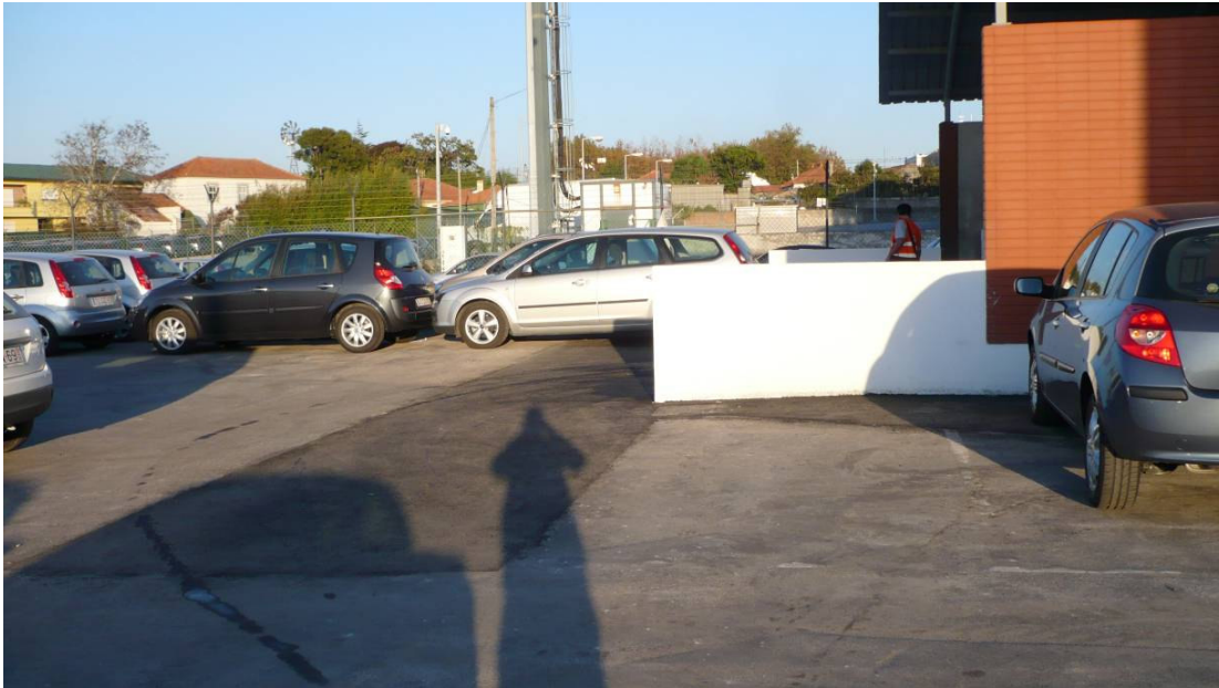
Fotografia 9 - Aspecto final de zona repavimentada.
