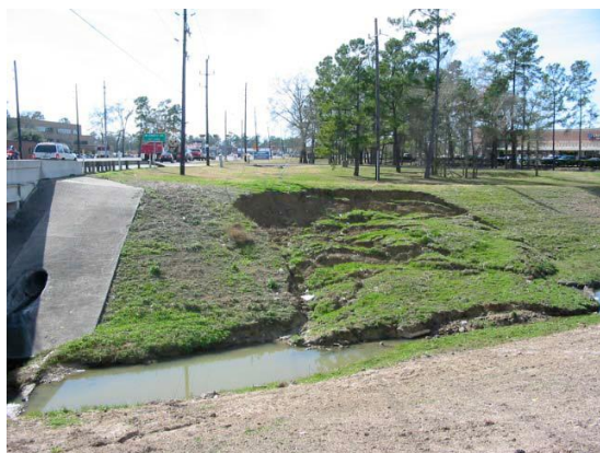
Figura 6.1 - Imagens da rotura de taludes [25] e [27].
