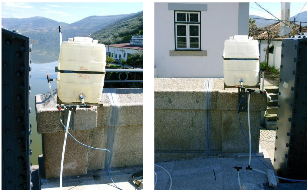
Fig. 4.45 - Ilustração dos sensores de pressão de referência DVT0S e DVT0N.
