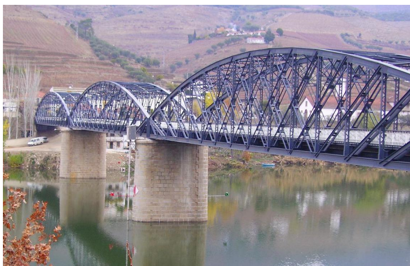
Fig 4.1 – Vista geral da Ponte do Pinhão.
