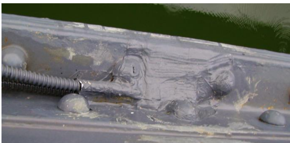
Fig. 4.72 — Ilustração do sensor de temperatura na secção S4.
