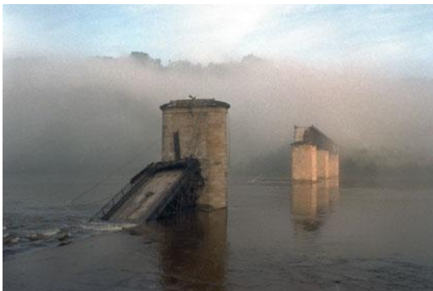
Fig. 3.3 – Ponte depois do acidente.
