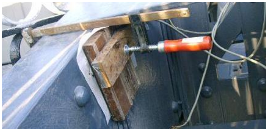
Fig. 2.10 – Aplicação de pressão mecânica durante a colagem da protecção.
