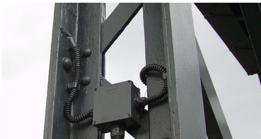
Fig. 4.41 — Ilustração dos extensómetros da secção S15.
