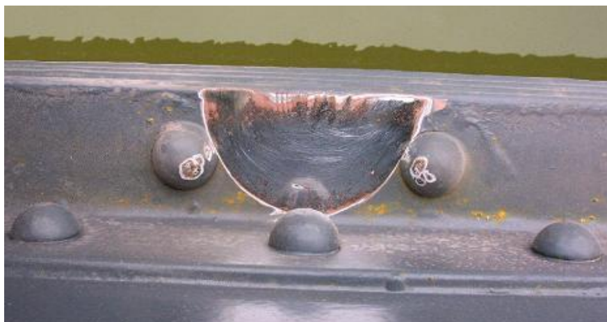
Fig.2.7 – Aspecto da superfície metálica rebarbada e limpa.
