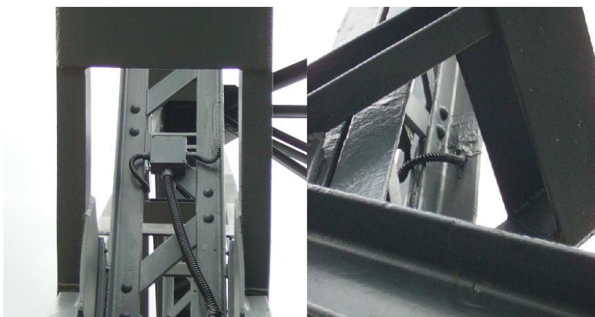
Fig. 4.37 — Ilustração dos extensómetros da secção S13.
