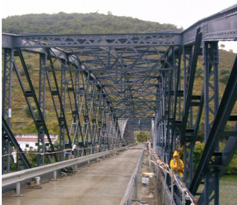
Fig. 4.12 – Contraventamento superior.
