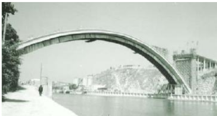
Fig. 1.2 - Fase da ripagem do cimbrio da Ponte da Arrábida (Quintela e Proença, 2001).
