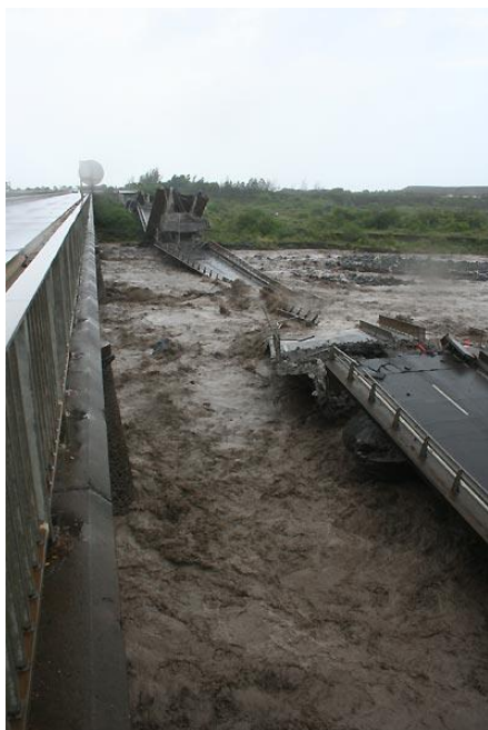
Fig. 3.1 – Tipo de acidente causado pela infraescavação.
