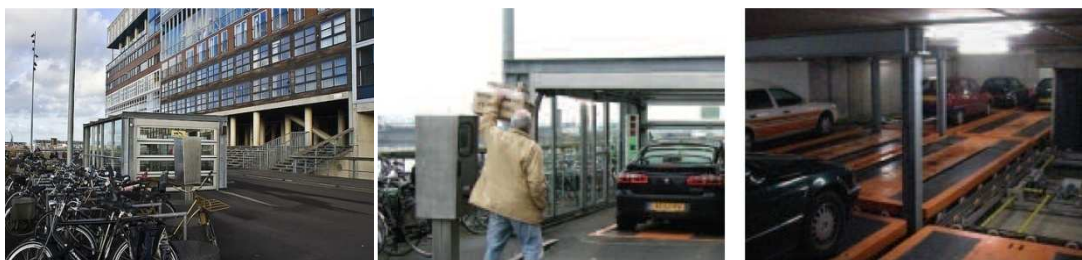
Figura 3-6 - Parque de estacionamento mecânico em Amsterdão (Silodam)
