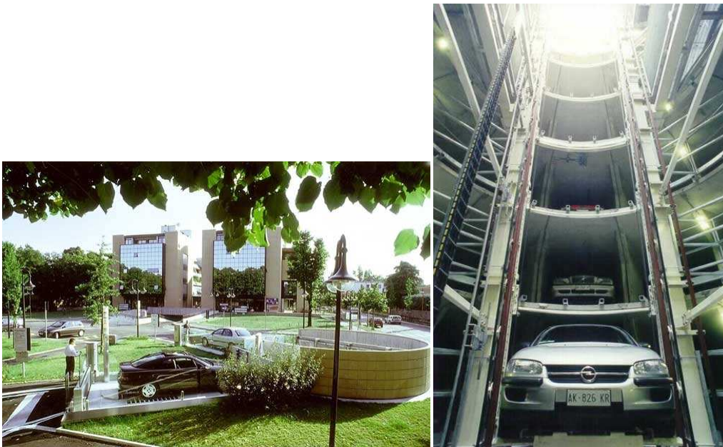
Figura 3-5 - Parque de estacionamento mecânico em Cesena (Fonte: Trevipark)
