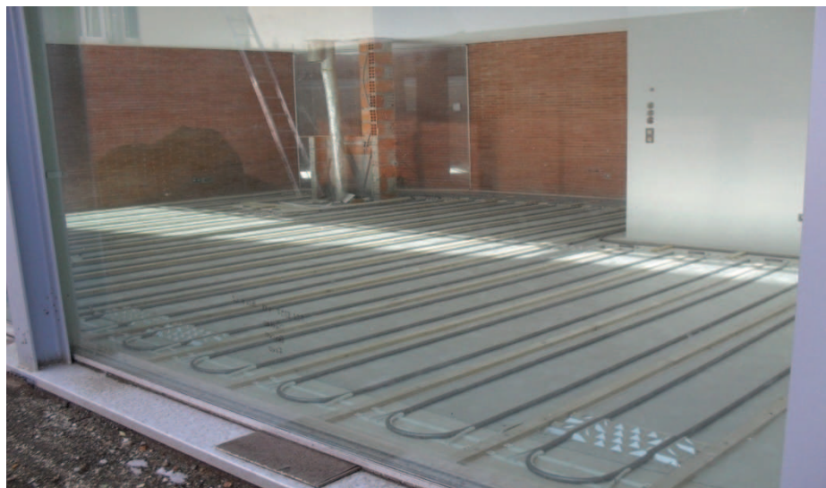
Fig. 53 – Colocação da tubagem em pavimento seco
