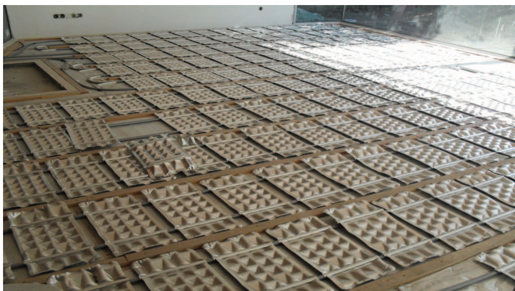
Fig. 54 – Colocação das placas de alumínio no pavimento seco
