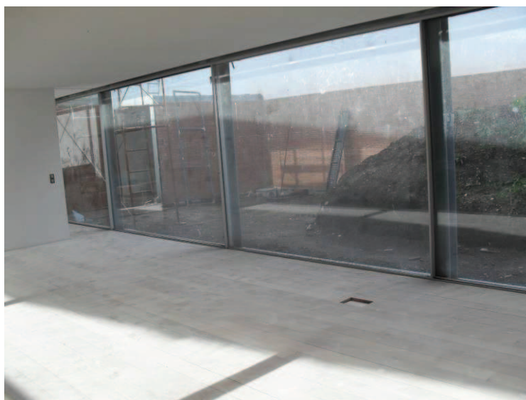
Fig. 23 – Fachada Sudoeste ao nível do rés-do-chão
