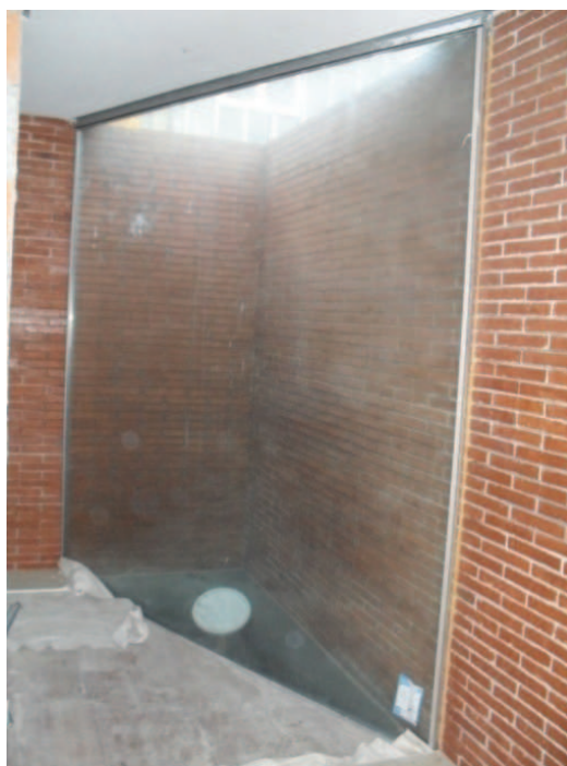
Fig. 28 – Envidraçado na sala
