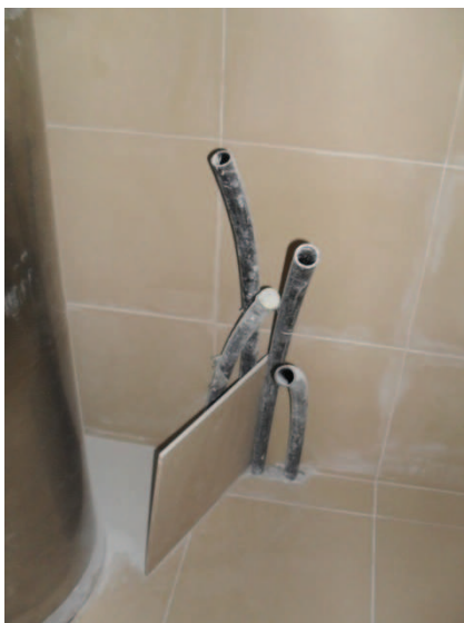
Fig. 45 – Saída dos tubos da sonda que ligarão à bomba de calor
