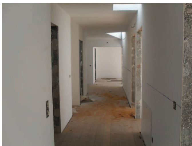
Fig. 16 – Corredor no 1º piso
