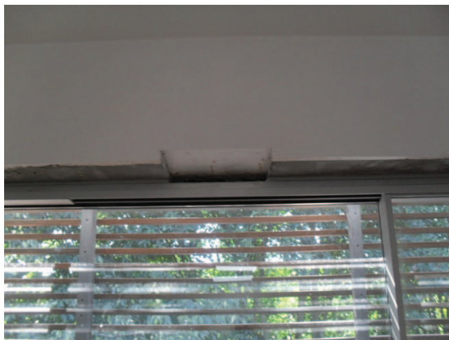
Fig. 40 – Abertura para grelhas de ventilação
