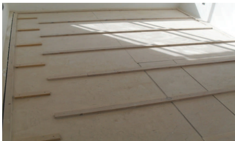
Fig. 52 – Colocação do ripado para o pavimento seco
