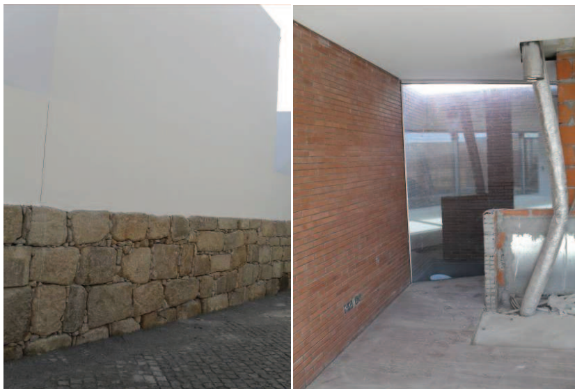
Fig. 22– Revestimento exterior e interior da fachada Noroeste, ao nível do rés-do-chão
