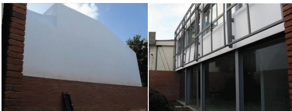
Fig. 4 – Vistas de fachadas da habitação
