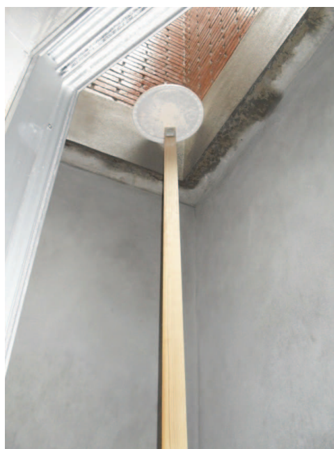
Fig. 85 – Sensor instalado no exterior
