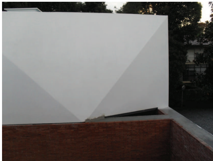
Fig. 11– Abertura ao nível do rés-do-chão
