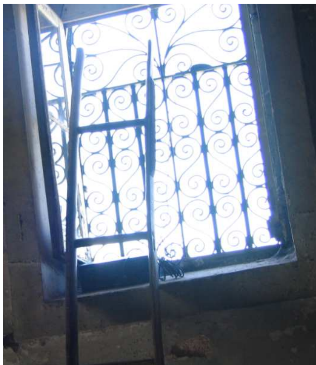
Fig.2.8- Vista interior da janela da fachada lateral da capela de N.Srª do Alívio
