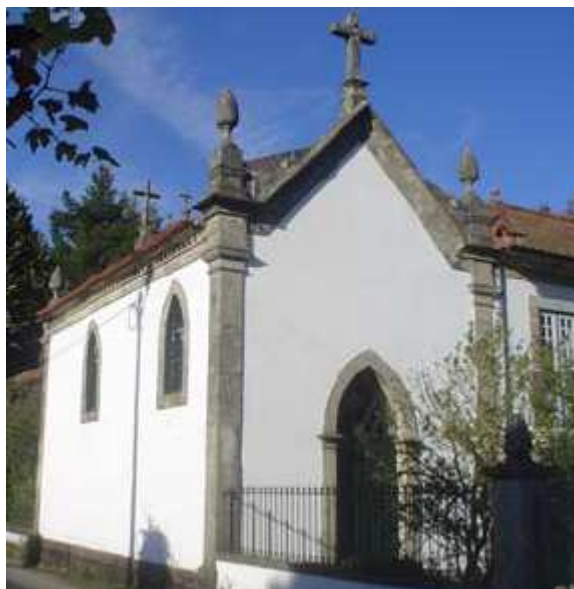
Fig.2.7- Vista exterior das janelas da fachada lateral da capela de N.Srª do Alívio
