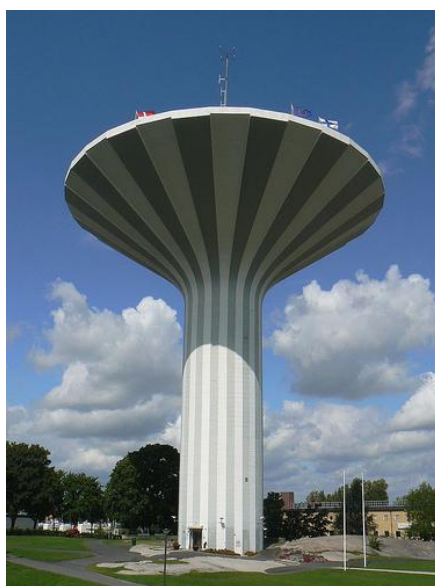
Fig. 1.3 – Reservatório elevado em Orebro, Suécia.
