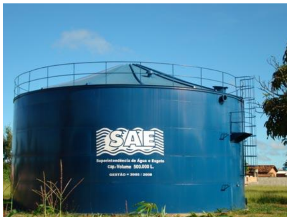
Fig. 1.2 – Exemplo de um reservatório metálico apoiado.
