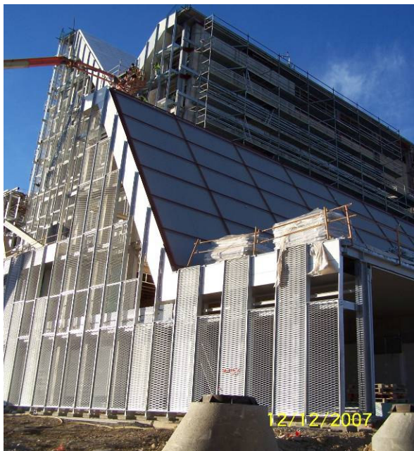
Figura 43- Fixação do deployé (exemplo 2).
