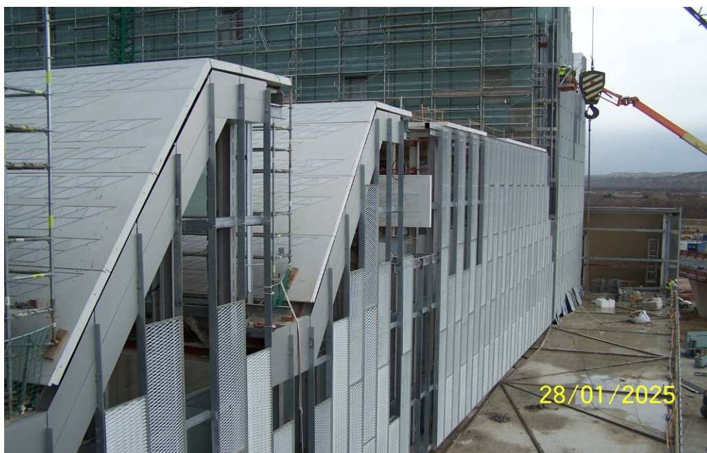
Figura 44- Fixação do deployé (exemplo 3).
