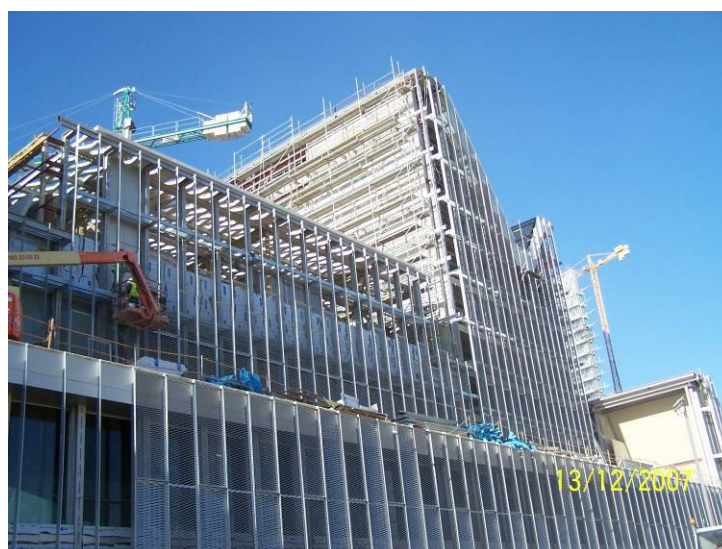
Figura 42- Fixação do deployé (exemplo1).
