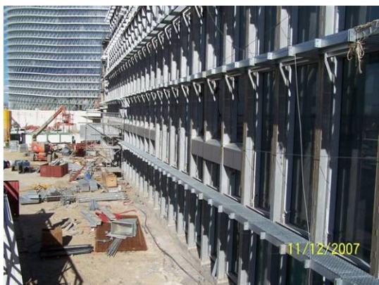
Figura 40- Estrutura suporte das barras.
