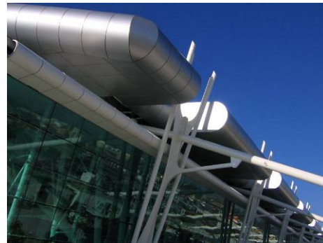
Figura 12- Pormenor de fachada em Alucobond.
