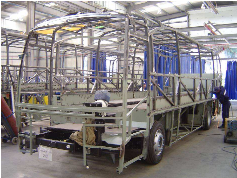
Figura 51 - Estrutura completa do Tourino
