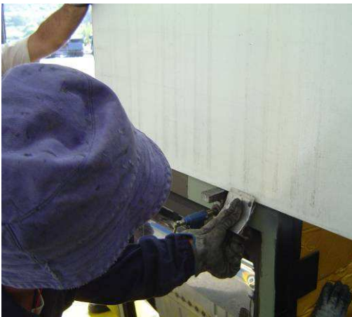
Figura 28 - Verificação de folgas com o painel já colado
