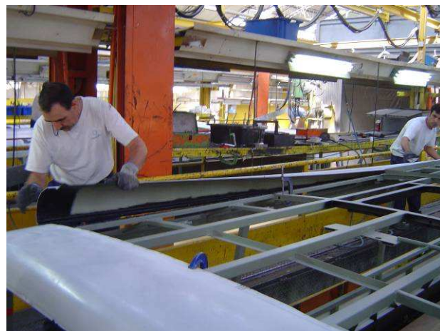
Figura 20 - Montagem das Sancas
