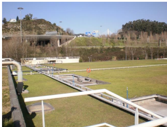
Figura 5 - Superfície exterior da ETAR do Freixo
