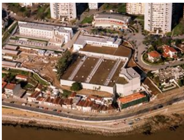
Figura 1 - Vista exterior da ETAR de Sobreiras
