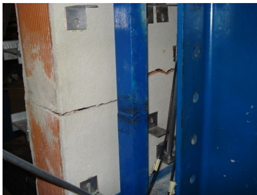
Figura 112 - Modo de rotura PRS
