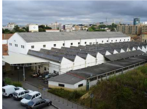
Figura 1 – Edifício da GEPC Portugal
