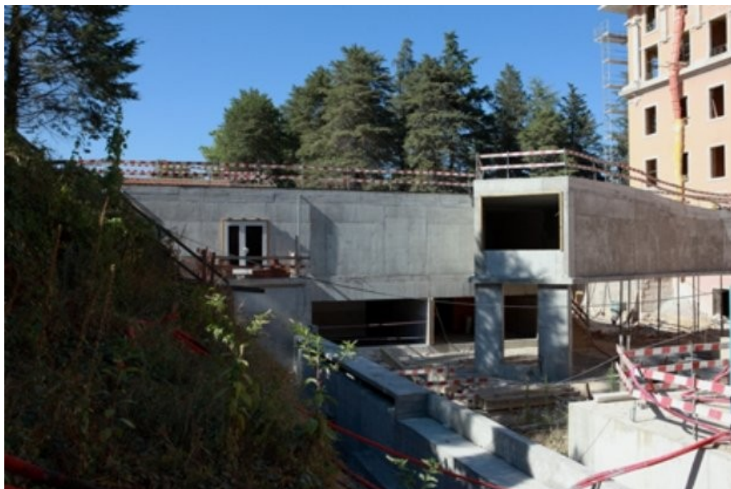
Figura 11 – Túnel de acesso entre o hotel e o spa. [62]
