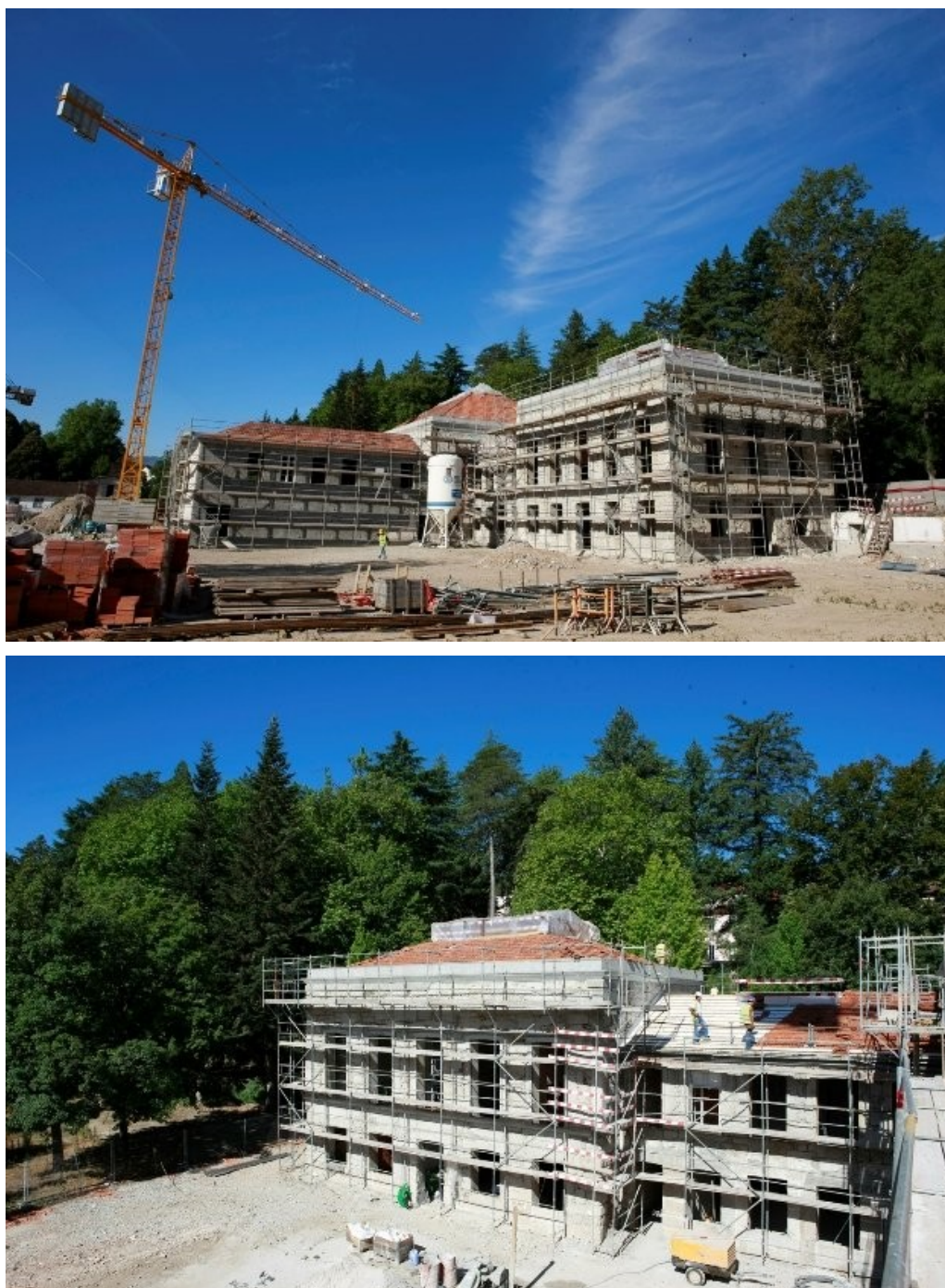
Figura 18 – Reabilitação do edifício do antigo balneário termal. [62]
