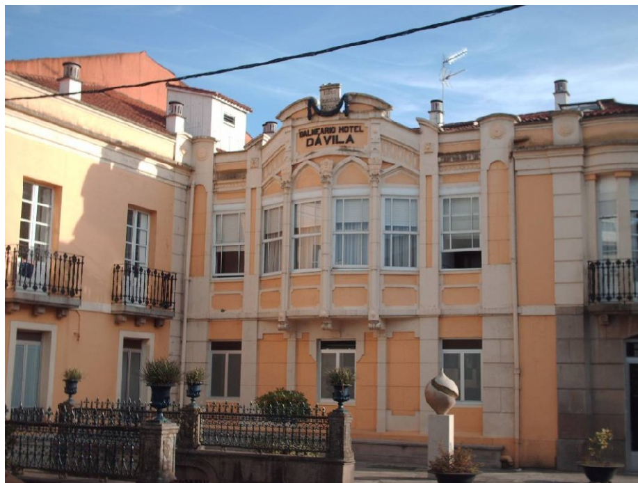
Figura 26 – Fachada principal do balneário Dávila. (Fotografia do autor)
