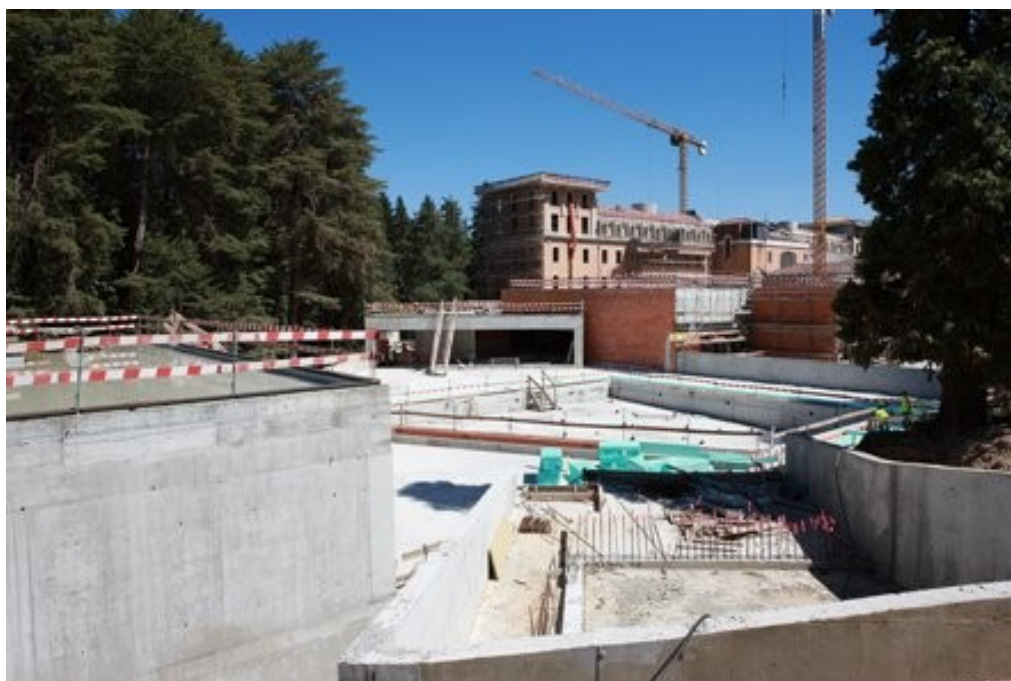
Figura 10 – Vista da reabilitação do hotel e construção do novo spa. [62]
