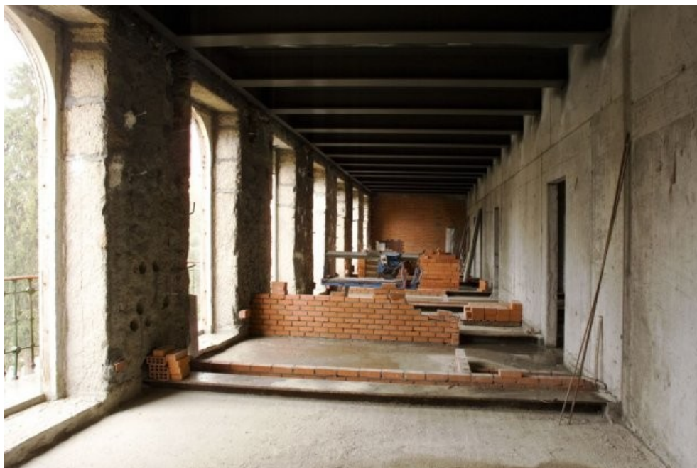
Figura 9 – Levantamento das paredes dos quartos. [62]
