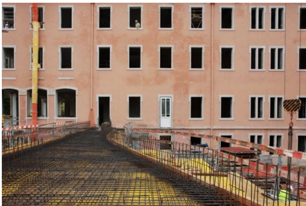
Figura 7 – Acesso entre o hotel e o spa. [62]
