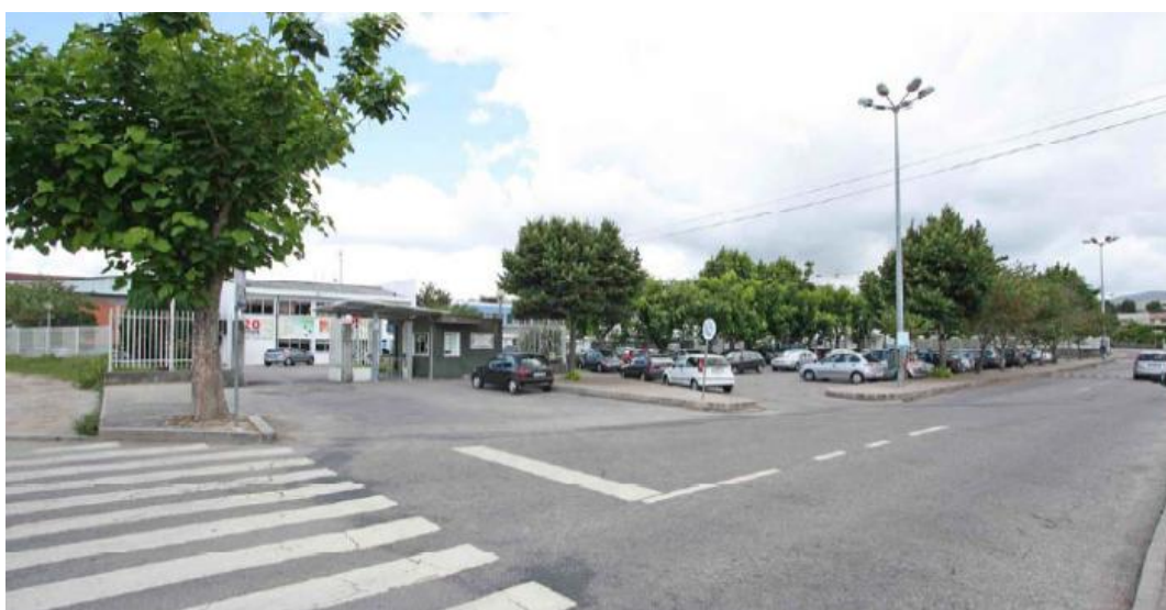
Fig.4.12. – Acesso à escola, portaria e parque exterior.
