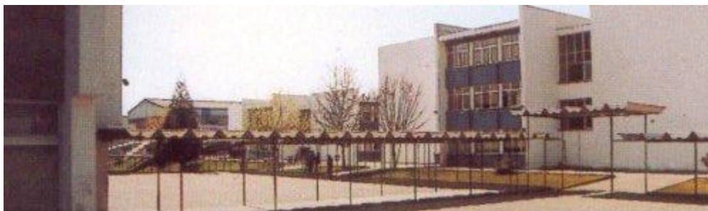
Fig.4.11. – Edifício com salas de aulas.
