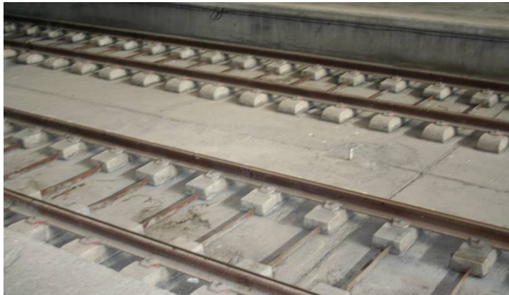
Fig. 21 – Contacto entre os carris e solipas Estação de Santa Justa (Sevilha). [Foto do autor].
